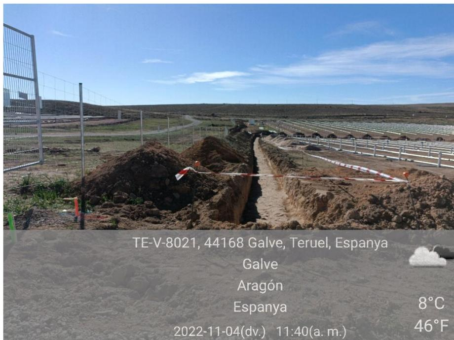
Ilustración 2. Zanja de media tensión junto al vallado en zona 2.
