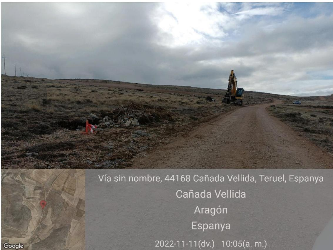
*Ilustración 4. Estaquillado junto a la vía pecuaria para la apertura de la zanja de la línea soterrada.*
