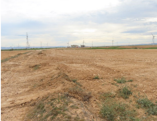
Reposición de suelos en préstamo de tierras, tras su cerrado y relleno con tierras sobrantes.
