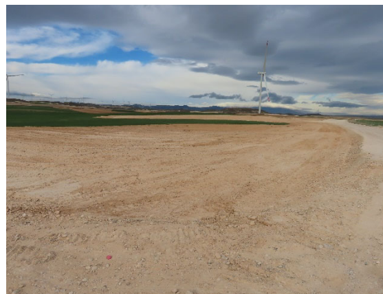
Descompactación de suelos en área auxiliar de Margalejo-Hnos. de Pablo.
