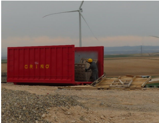
Retirada de residuos de madera de las obras.
