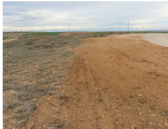
Retirada de tierras acopiadas y extendido de tierra vegetal en las áreas de matorral afectadas por las obras.
