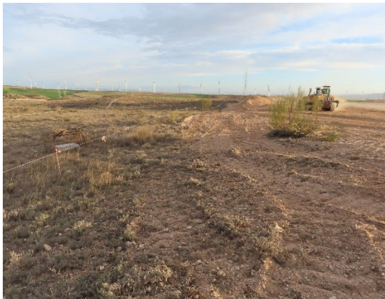
Retirada de tierras acopiadas y extendido de tierra vegetal en las áreas de matorral afectadas por las obras.
