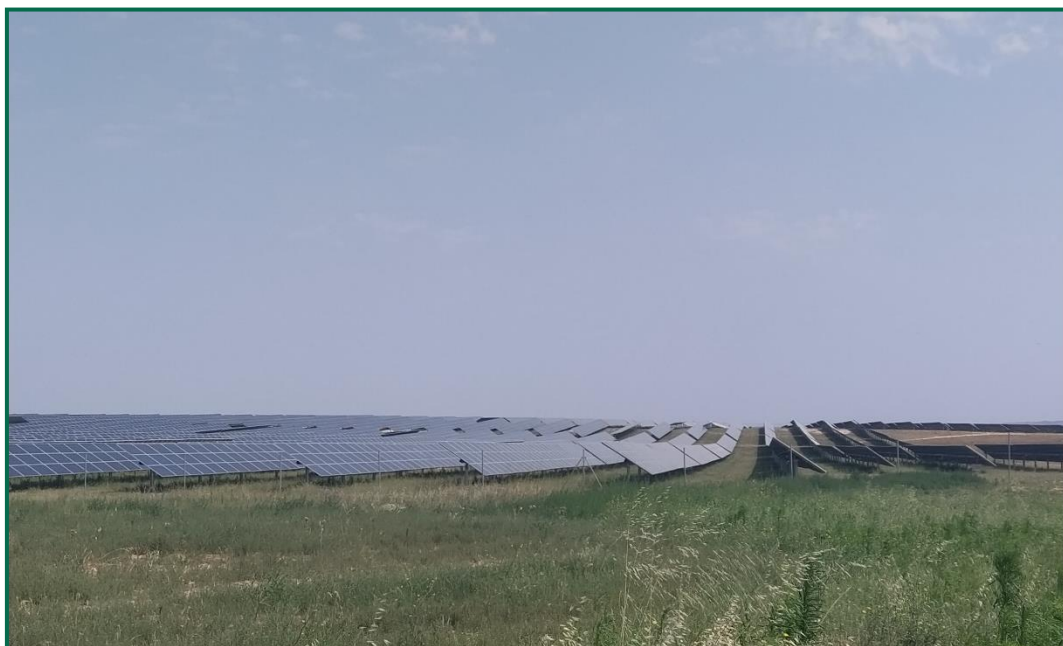
Fotografía 1. Vegetación entre placas en su estado actual.
