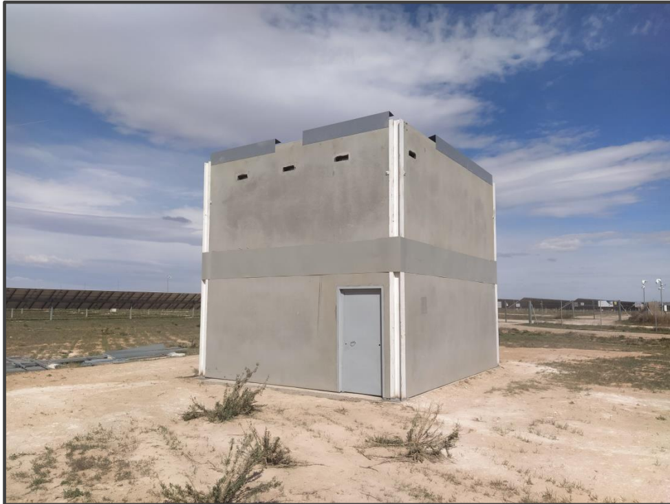
Fotografía 4. Exterior del primillar de nueva construcción.
