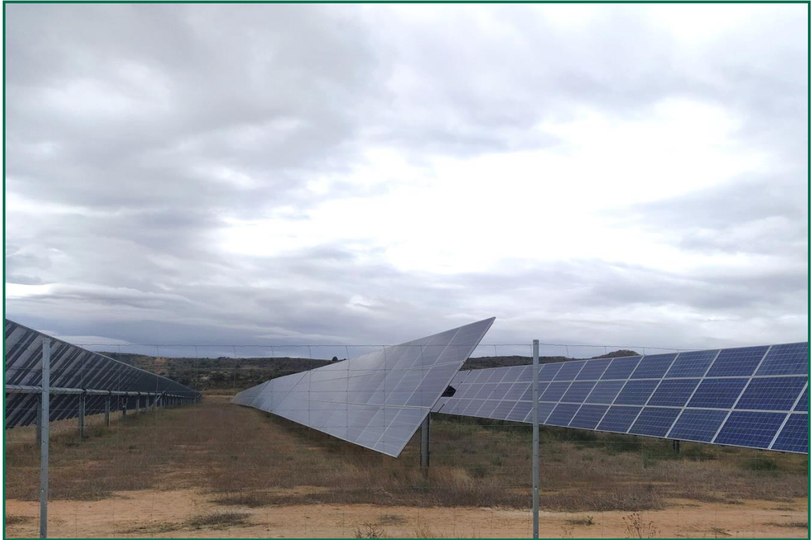
Fotografía 1. Vegetación entre placas actualmente.
