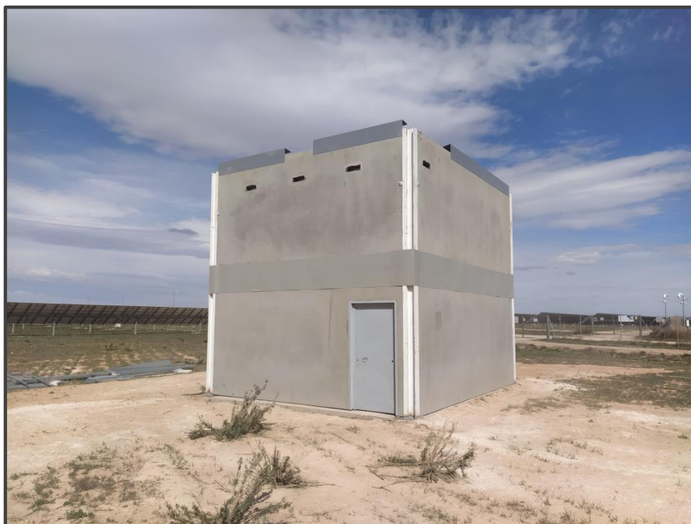
Fotografía 4. Exterior del primillar de nueva construcción.
