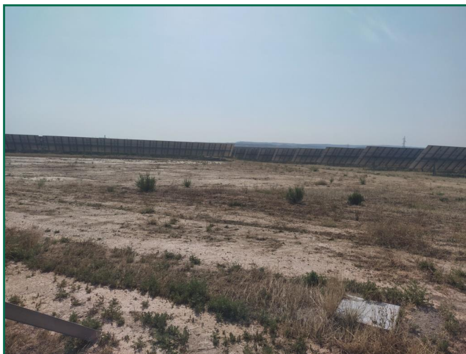
Fotografía 3. Zona revegetada en su estado actual.
