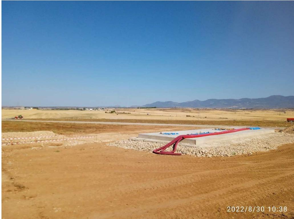
Imagen 5.- Cimentación de uno de los 3 Centros de transformación terminada.
