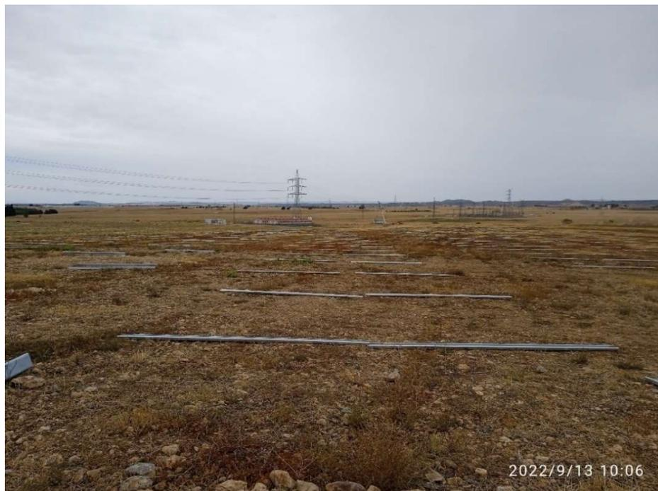
Imagen 2. Postes de cimentación de los seguidores dispuestos para su hincado.
