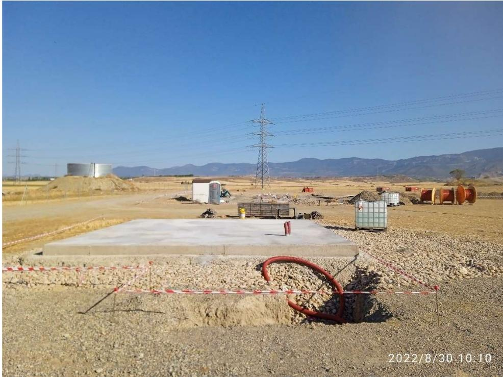
Imagen 9.- Trabajos en los cimientos de la futura Subestación de la PSFV.
