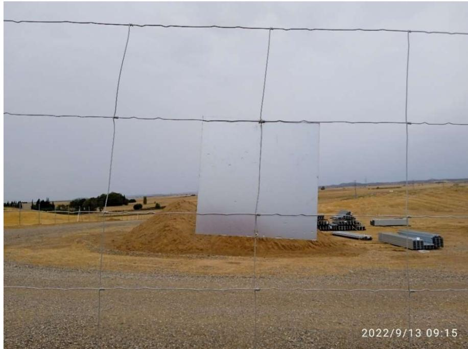
Imagen 1. Placa metálica anticolidión de avifauna colocada en el vallado perimetral.
