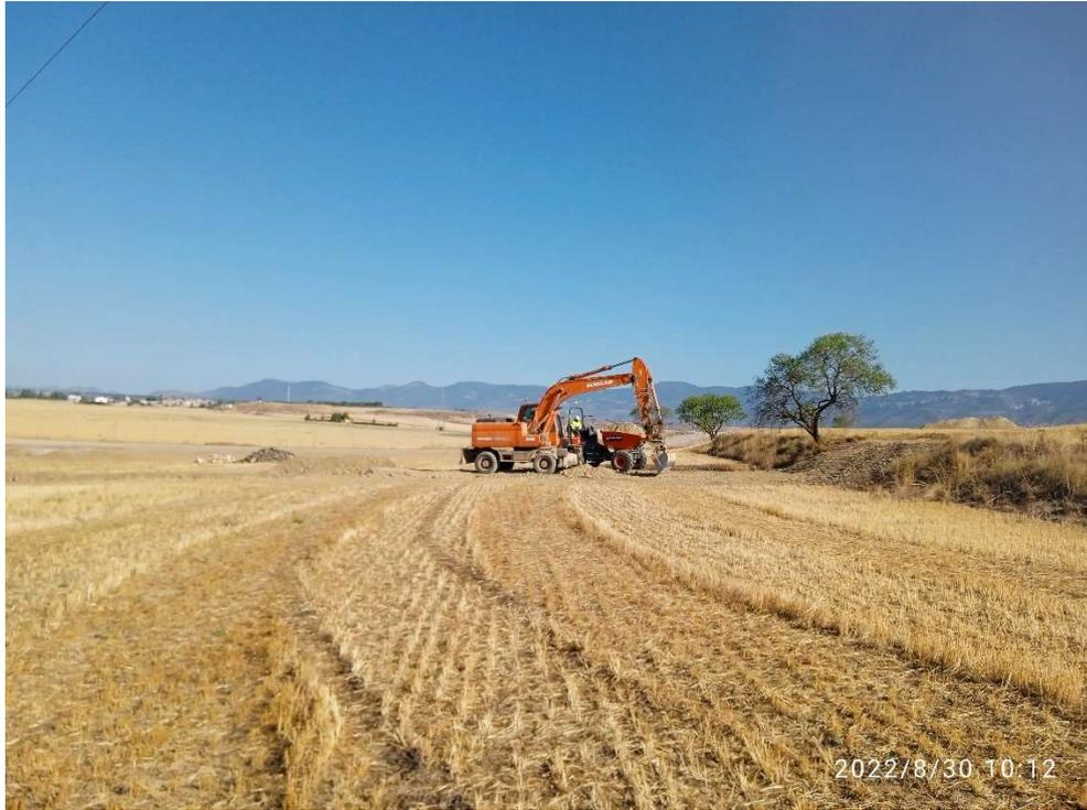
Imagen 7. Trabajos de relleno de la zanja para conducciones de media tensión.
