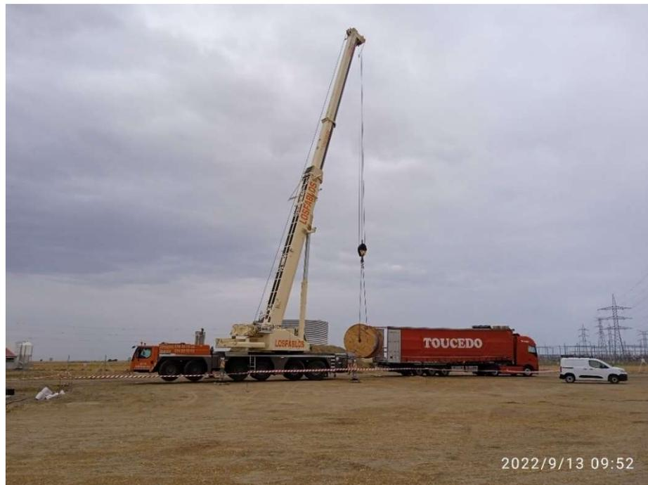
Imagen 9.- Descarga de cable de alta tensión para la futura Subestación de la PSFV.
