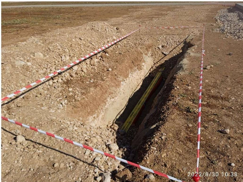
Imagen 6.- Vista de las conducciones de media tensión cerca de los cimientos del C.T. Se aprecia que una vez cubierta la zanja, el terreno queda igualado.
