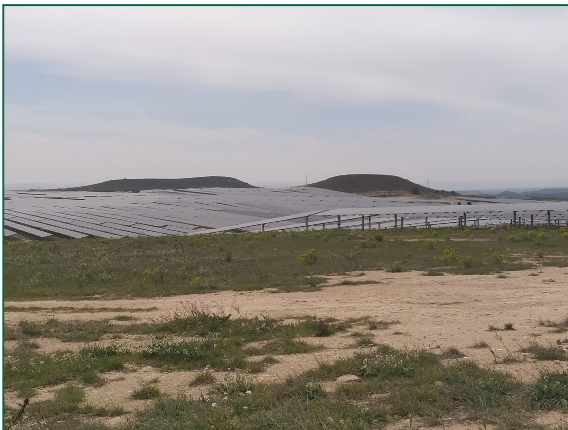
Fotografía 1. Vegetación entre placas actualmente.
