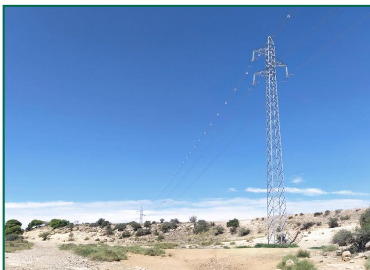
Fotografía 2. Línea eléctrica con balizas salvapájaros
