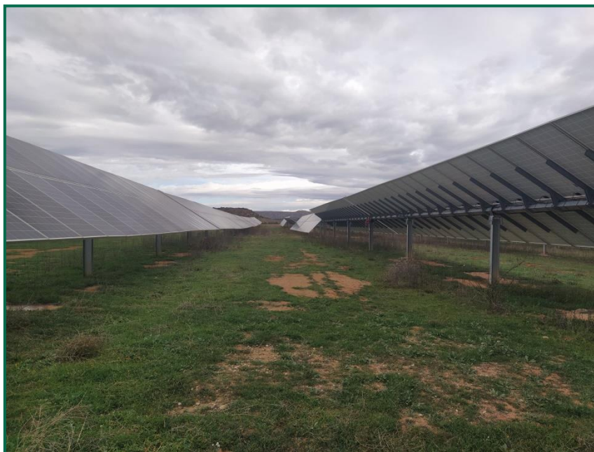
Fotografías 1 y 2. Vegetación entre placas actualmente.
