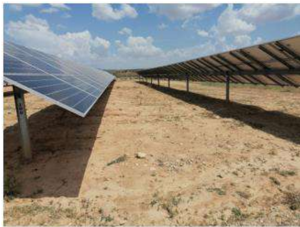
Fotografía 95. -Estado del suelo en bloques de construcción reciente. Cubierta vegetal rala y escasa. Mayo 2023.
