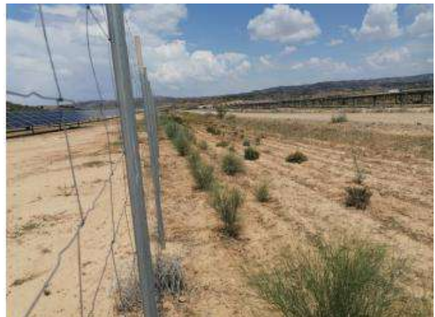
Fotografía 118. -Estado de la pantalla perimetral en torno a la pista central (semi-recinto Oeste). Mayo 2023.
