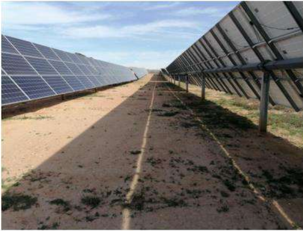
Fotografía 31.- Estado del suelo en bloques de construcción reciente. Marzo 2023.
