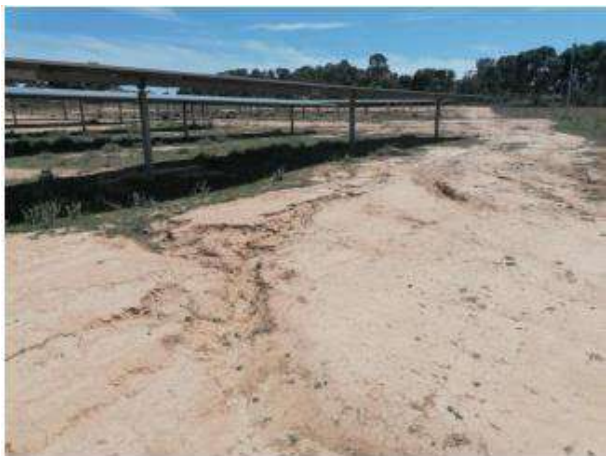
Fotografía 71.- Procesos erosivos. Cárcavas y arrastres bajo seguidores. Abril 2023.
