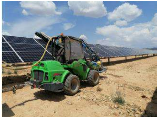
Fotografía 108. -Procesos erosivos Cárcavas y arrastres bajo seguidores y caminos de servicio. Dificultades y ocasionalmente imposibilidad para el paso de vehículos. Mayo 2023.
