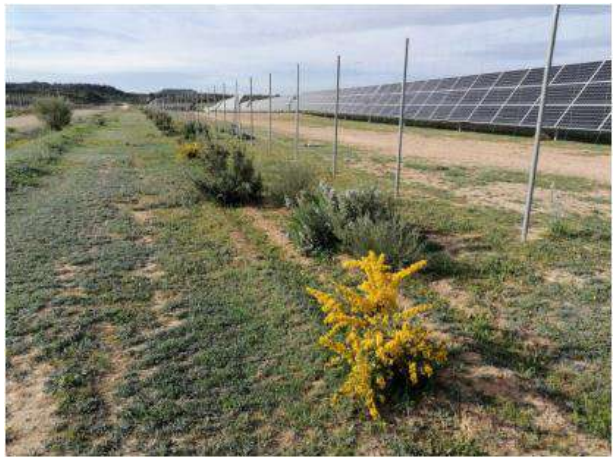
Fotografía 48.- Estado de la pantalla perimetral en torno a la pista central (semi-recinto Oeste). Marzo 2023.
