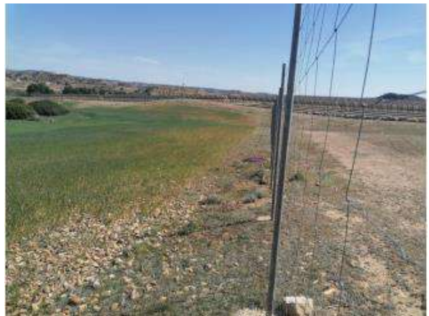
Fotografía 78.- Estado de la pantalla en el tramo próximo al Camino Natural del Ebro (GR-99. Plantación de tamariz en semi-recinto Este lado Norte). Abril 2023.
