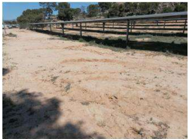
Fotografía 70.- Procesos erosivos. Cárcavas y arrastres bajo seguidores. Abril 2023.
