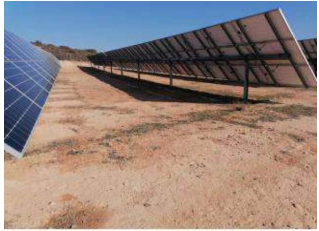
Fotografía 02.- Estado del suelo en bloques de construcción reciente. Cubierta vegetal rala y escasa. Febrero 2023.
