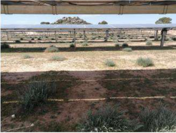
Fotografía 67.- Estado del suelo en bloque de construcción reciente. Cubierta vegetal rala y escasa. Abril 2023.
