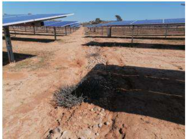
Fotografía 10.- Procesos erosivos. Cárcavas y arrastres bajo seguidores. Febrero 2023.
