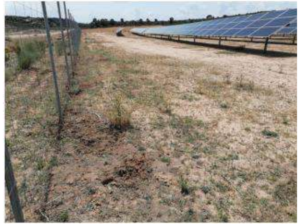
Fotografía 122. -Permeabilidad del vallado: rastros de jabalí a ambos lados del vallado. Mayo 2023.
