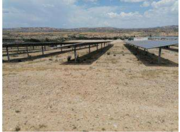
Fotografía 98. -Estado del suelo en bloques de construcción reciente. Cubierta vegetal rala y escasa. Mayo 2023.
