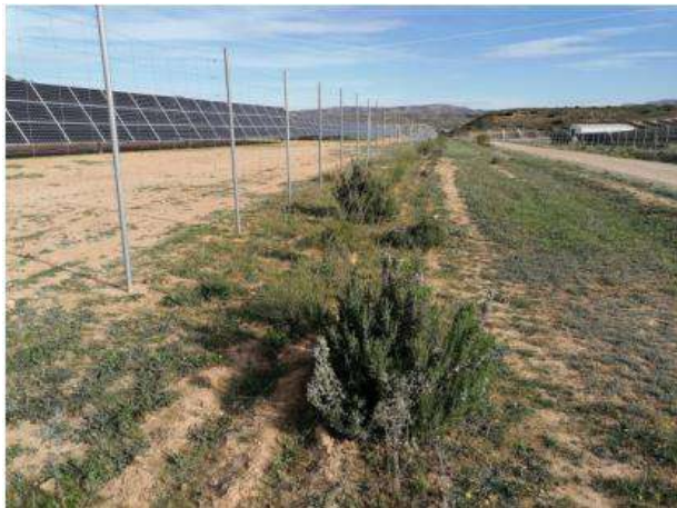
Fotografía 47.- Estado de la pantalla perimetral en torno a la pista central (semi-recinto Oeste). Marzo 2023.
