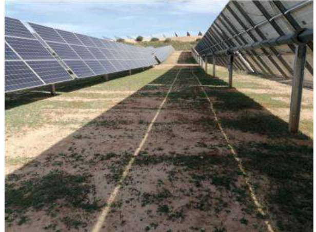
Fotografía 32.- Estado del suelo en bloques de construcción reciente. Cubierta vegetal rala y escasa. Marzo 2023.
