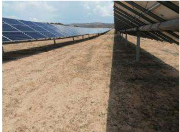
Fotografía 96. - Estado del suelo en bloques de construcción reciente. Cubierta vegetal rala y escasa. Mayo 2023.
