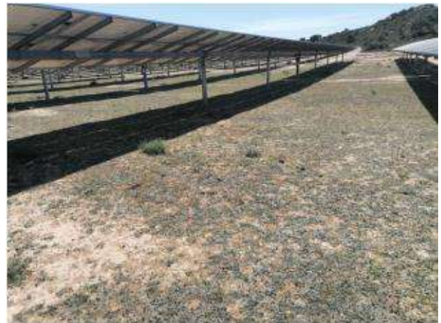
Fotografía 66.- Estado del suelo en bloque de construcción reciente. Cubierta vegetal rala y escasa. Abril 2023.
