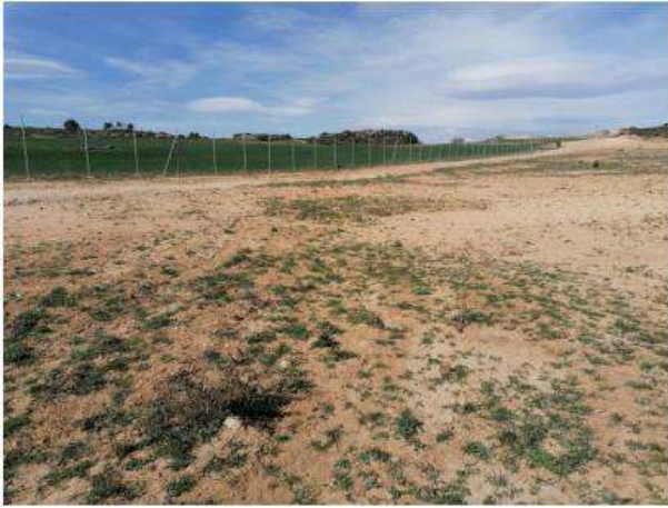
Fotografía 37.- Estado de las zonas preparadas para la hidrosiembra: Cubierta vegetal rala y escasa. Marzo 2023.
