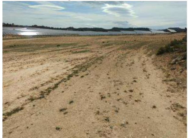
Fotografía 36.- Estado de las zonas preparadas para la hidrosiembra: Cubierta vegetal rala y escasa. Marzo 2023.
