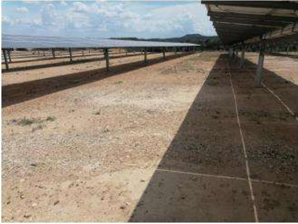
Fotografía 97. -Estado del suelo en bloques de construcción reciente. Cubierta vegetal rala y escasa. Mayo 2023.
