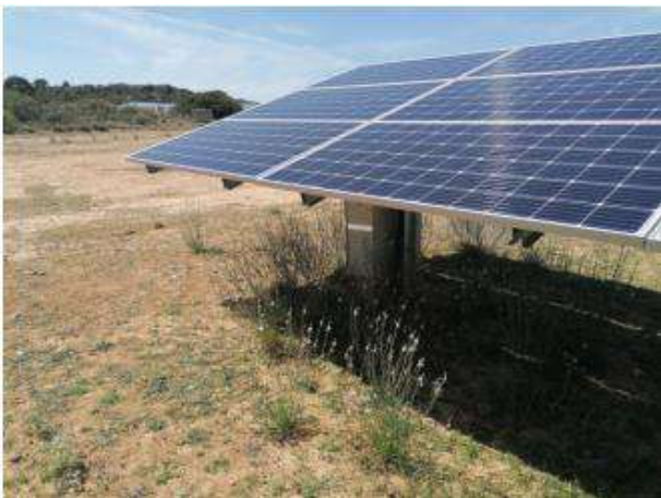
Fotografía 69.- Procesos erosivos. Cárcavas y arrastres bajo seguidores. Abril 2023.
