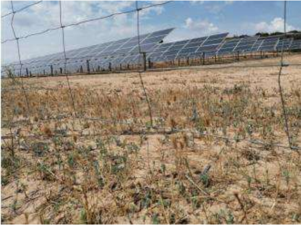
Fotografía 121. -Permeabilidad del vallado: Detalle del espacio bajo el vallado. Mayo 2023.
