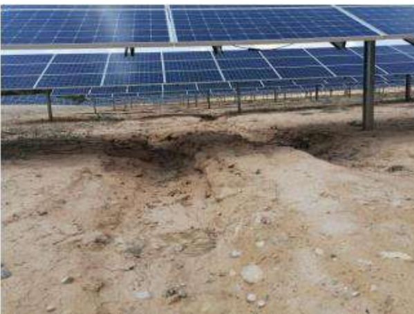
Fotografía 107. -Procesos erosivos Cárcavas y arrastres bajo seguidores y caminos de servicio. Mayo 2023.
