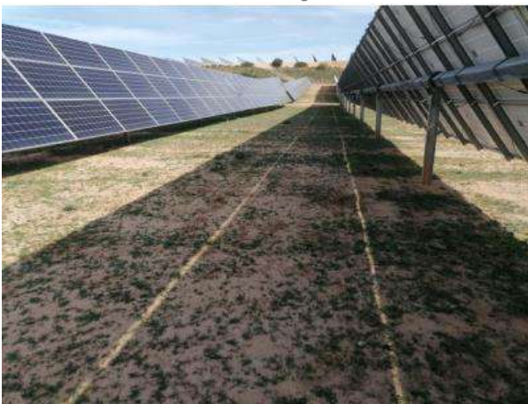
Fotografía 33.- Estado del suelo en bloques de construcción reciente. Cubierta vegetal rala y escasa. Marzo 2023.
