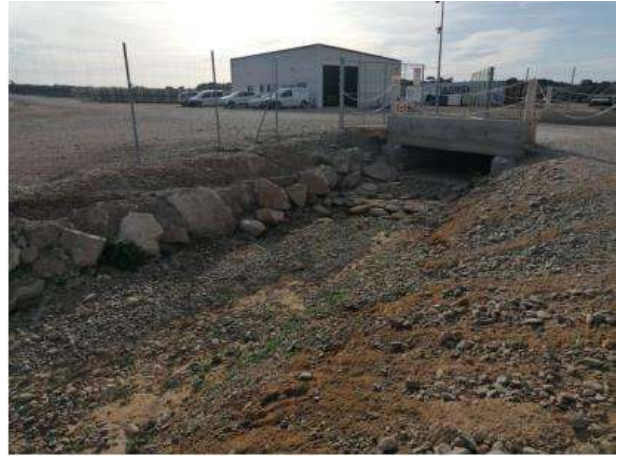
Fotografía 38.- Procesos erosivos. Cuneta reparada bajo puente de acceso a PSFV. Marzo 2023.
