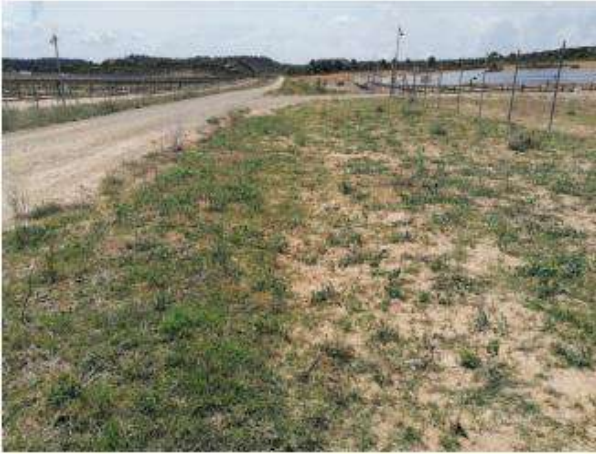
Fotografía 109. -Procesos erosivos. Cuneta colmada por arrastre de limos y arcillas desde el interior de la PSFV. Mayo 2023.
