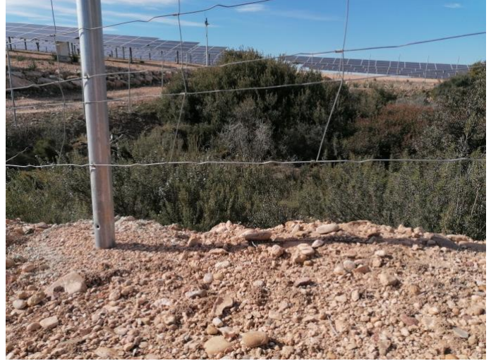
Fotografía 68.- Permeabilidad del vallado: Espacio entre el vallado y el suelo que posibilita el paso de fauna. Enero 2023
