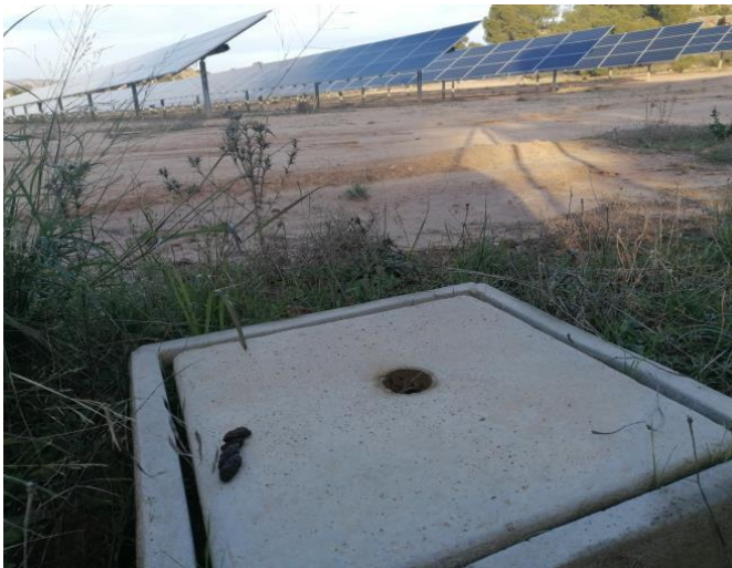
Fotografía 45.- Permeabilidad del vallado: Excrementos de zorro. Noviembre 2022
