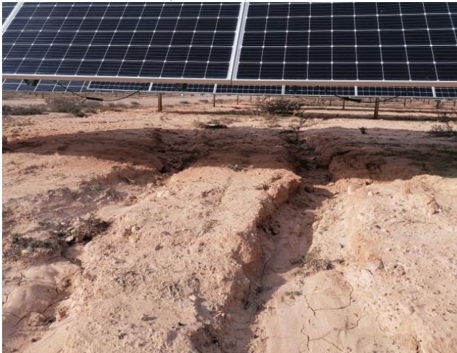
Fotografía 27.- Procesos erosivos. Cárcavas y arrastres bajo seguidores. Enero 2023
