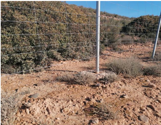
Fotografía 57.- Permeabilidad del vallado: Espacio bajo el vallado. Diciembre 2022
