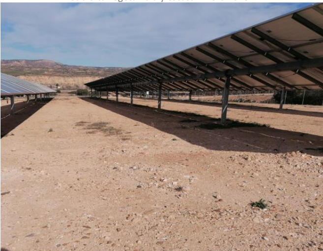
Fotografía 05.- Estado del suelo en bloques de construcción reciente. Cubierta vegetal rala y escasa. Enero 2023
