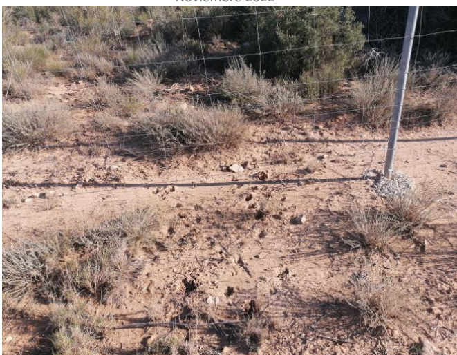
Fotografía 47.- Permeabilidad del vallado: Paso de jabalí. Noviembre 2022
