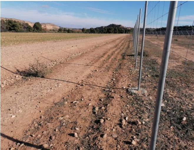
Fotografía 15.- Estado de las plantaciones perimetrales (semi-vallado Este, lado Norte). Noviembre 2023
