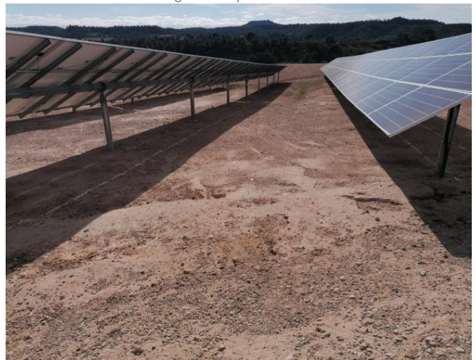
Fotografía 06.- Estado del suelo en bloques de construcción reciente. Cubierta vegetal rala y escasa. Enero 2023
