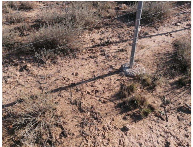
Fotografía 46.- Permeabilidad del vallado: Paso de jabalí. Noviembre 2022
