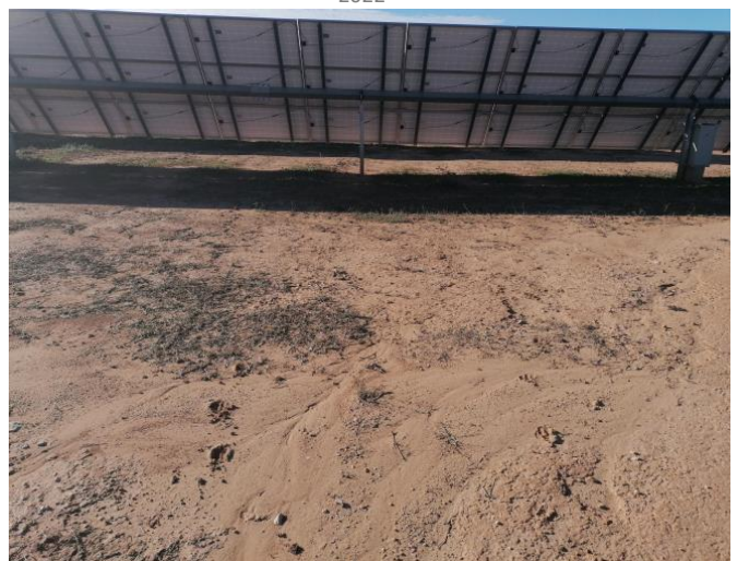
Fotografía 48.- Permeabilidad del vallado: Huellas de jabalí dentro de las instalaciones. Noviembre 2022
