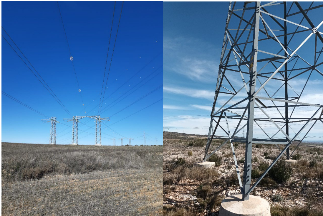
Fig 1 y 2. Imágenes balizas salvapájaros en el recorrido de la LAAT y chapa identificativa del apoyo
