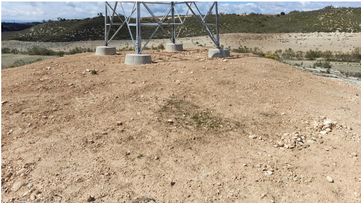
Estado de la hidrosiembra del apoyo 6 a finales del mes de marzo.
