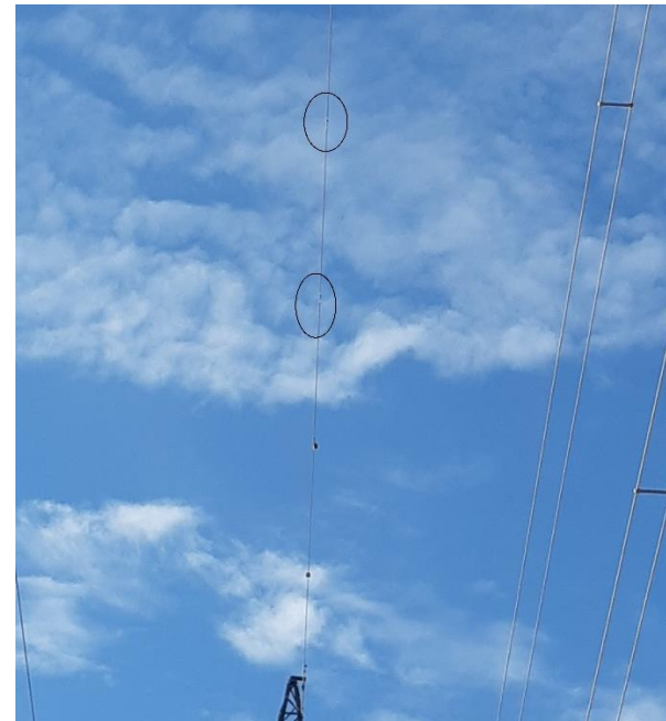
Fig. 1. Baliza salva-pájaros en el suelo, y puntos marcados en el cable toma-tierra donde faltan estas balizas.
