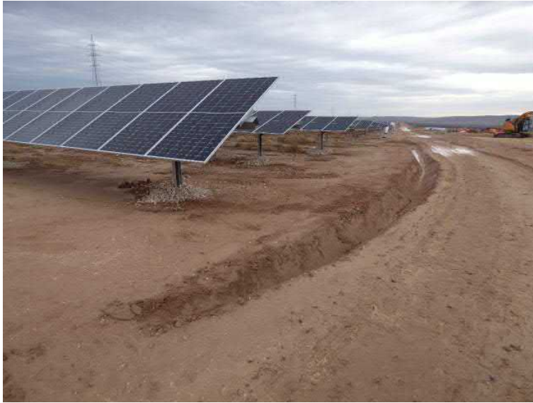
Figura 6. Cuneta acondicionada en la margen de un camino interior de la planta fotovoltaica
