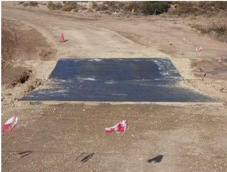
Figura 7. Uno de los badenes acondicionados en el camino perimetral
