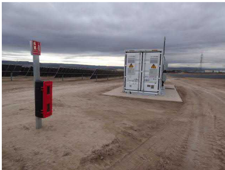
Figura 18. Extintor junto a uno de los centros de transformación
