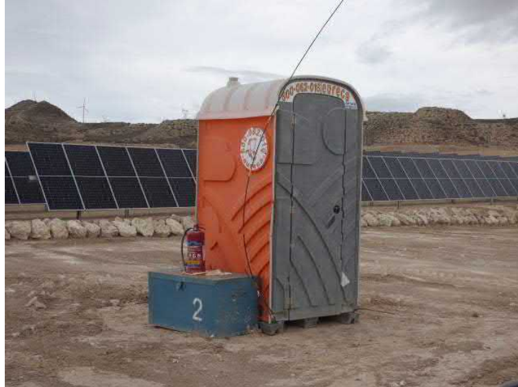
Figura 19. Extintor junto a uno de los baños químicos situado en el interior de la planta fotovoltaica
