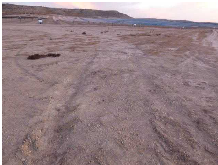
Figura 52. Tras el desmantelamiento del punto para la limpieza de hormigoneras, se ha restituido el terreno a su situación original
