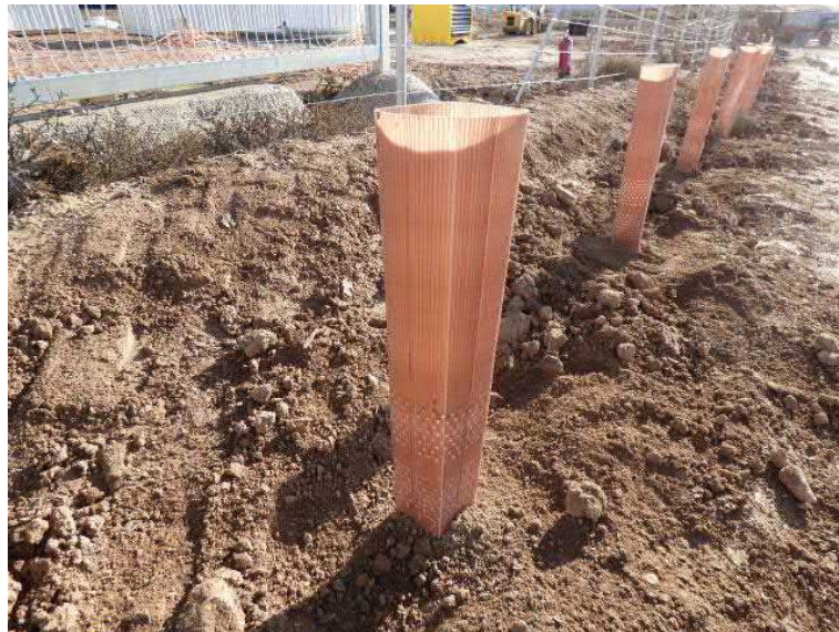
Figura 47. Pantalla vegetal plantada a 1,5 m del vallado perimetral y de manera paralela a éste
