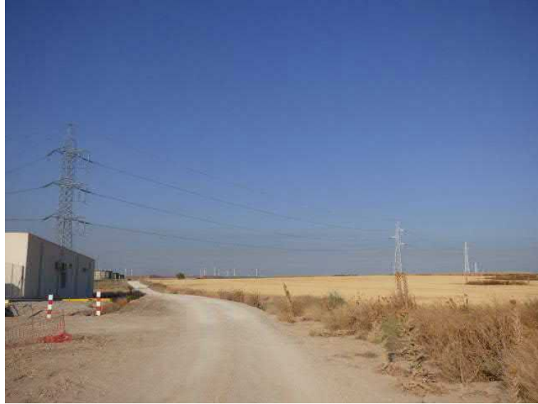
Figura 53. Camino de acceso existente desde el polígono industrial "El Pitarco"
