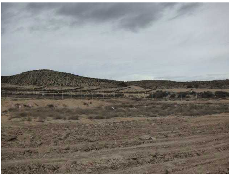
Figura 41. Área de vegetación natural balizada en el interior de la planta fotovoltaica que no ha sido alterada como consecuencia de la ejecución de las obras
