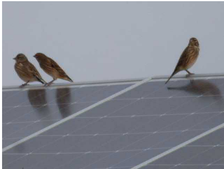
Figura 26. Bando de pardillo común posados sobre las placas fotovoltaicas
