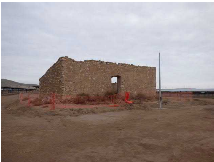
Figura 39. "Caseta de la Plana de la Muela 1" adecuadamente balizada
