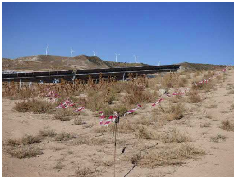
Figura 16. Durante este tercer y último cuatrimestre se ha mantenido en unas adecuadas condiciones el balizamiento de las áreas de vegetación natural situadas en el interior de la planta fotovoltaica
