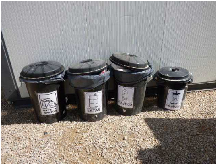
Figura 48. Contenedores identificados para el depósito de residuos urbanos, situados junto a las casetas de obra
