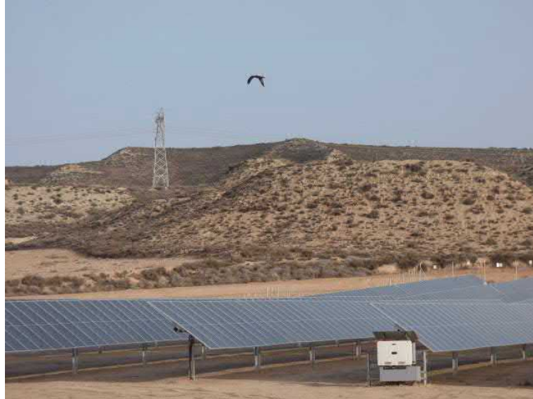
Figura 22. Ejemplar de milano real sobrevolando la planta fotovoltaica “Torrubia”
