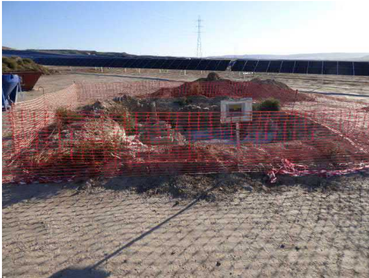
Figura 51. Punto acondicionado para el vertido del hormigón sobrante y la limpieza de las canaletas de las hormigoneras
