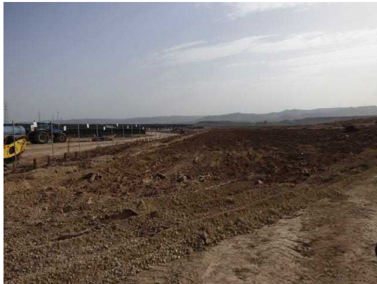
Figura 14. Se ha labrado la anterior zona de instalaciones auxiliares (situada en el exterior de la planta fotovoltaica) y posteriormente se ha sembrado con gramíneas y leguminosas
