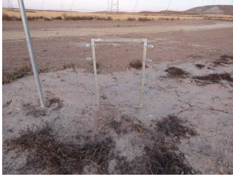
Figura 32. Paso de fauna instalado en el vallado perimetral
