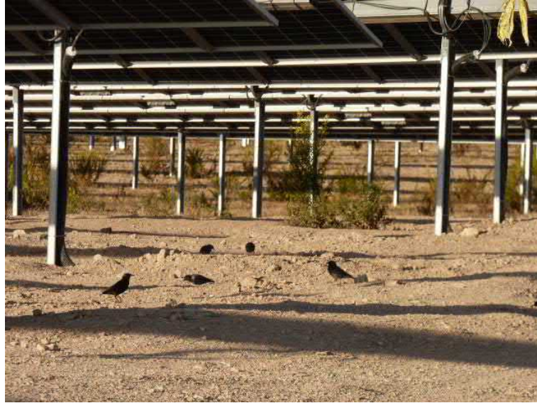
Figura 25. Bando de estorninos en el interior de la planta fotovoltaica
