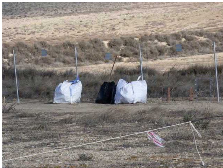
Figura 50. Periódicamente el contratista ha realizado batidas para la retirada de los residuos esparcidos por el viento tanto en el interior como en el exterior de la planta fotovoltaica
