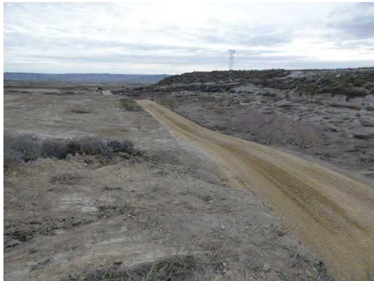
Figura 54. Camino perimetral que discurre al Oeste de la planta fotovoltaica
