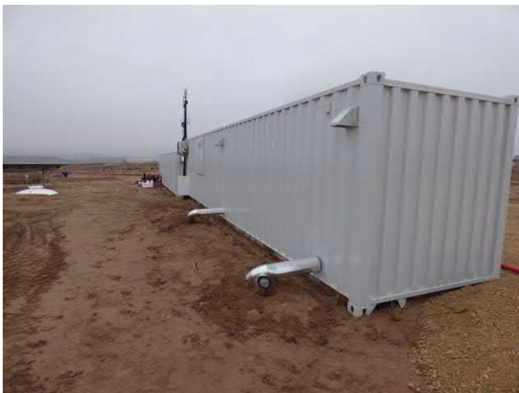
Figura 10. Las aguas residuales generadas en los baños disponibles en las casetas de obra son almacenadas temporalmente en un depósito estanco (visible al fondo de la imagen)
