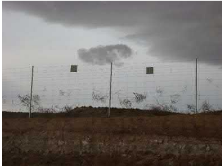
Figura 35. En las filas superiores del vallado perimetral se han instalado al tresbolillo las placas metálicas para incrementar la visibilidad del mismo por parte de la avifauna
