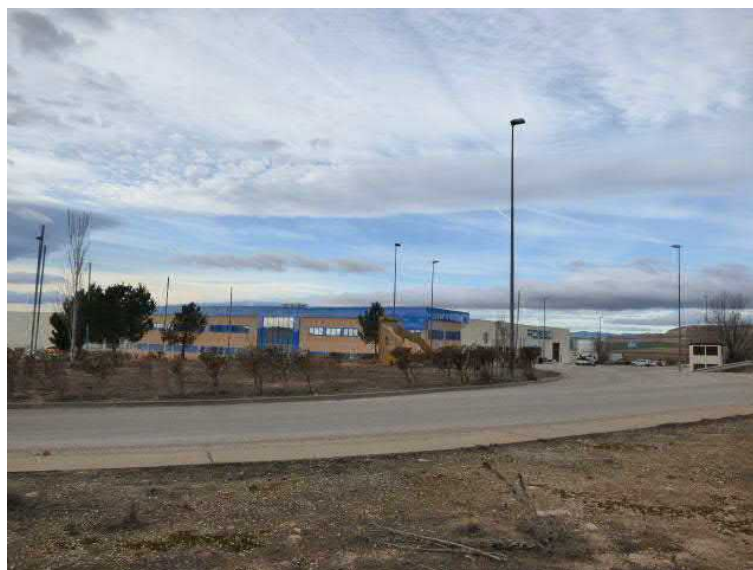
Figura 5. En el polígono industrial "El Pitarco" no se han detectado acumulaciones de polvo procedentes de la obra
