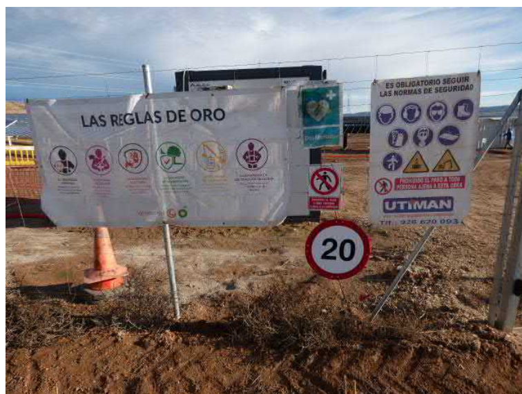
Figura 36. Señal de limitación de velocidad 20 km/h instalada junto a la puerta de acceso a la planta fotovoltaica
