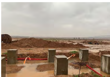
Figura 4 Trabajos de cimentación
