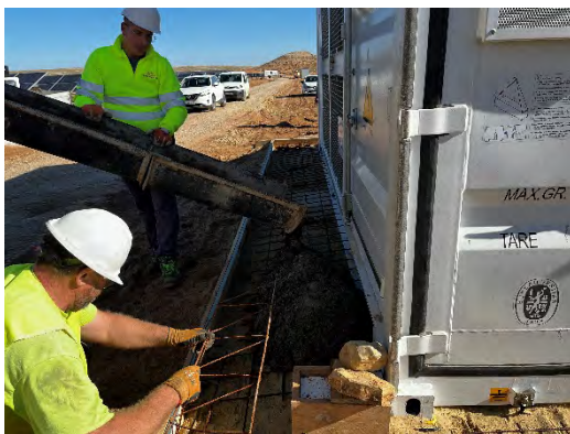
Figura 26 Labores de cimentación
