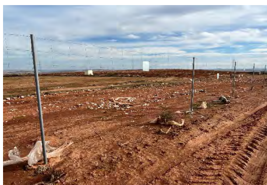
Figura 40 Instalación del vallado perimetral
