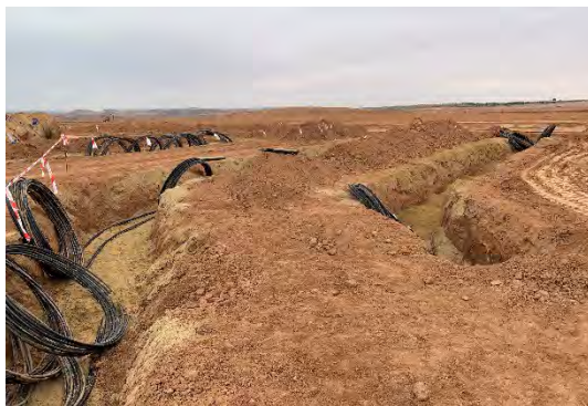
Figura 9 Tendido de cable de baja tensión
