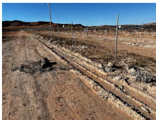
Figura 25 Vertidos de hormigón
