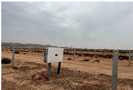
Figura 11 Montaje de los inversores
