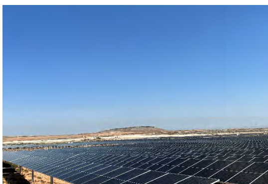
Figura 8 Montaje de los módulos fotovoltaicos
