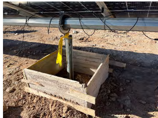
Figura 27 Encofrado de las hincas rechazadas
