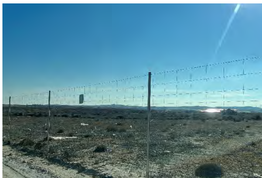
Figura 39 Instalación del vallado perimetral
