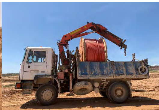
Figura 10 Tendido de cable de media tensión
