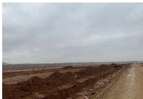
Figura 3 Apertura de zanjas
