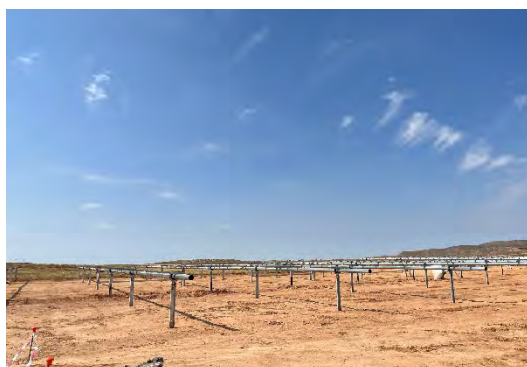
Figura 7 Montaje de los trackers
