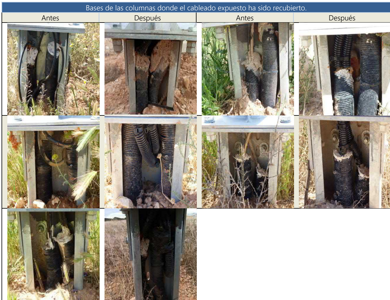
Imágenes 6, 7, 8, 9, 10, 11, 12, 13, 14 y 15: bases de las columnas antes y después de la protección del cableado
