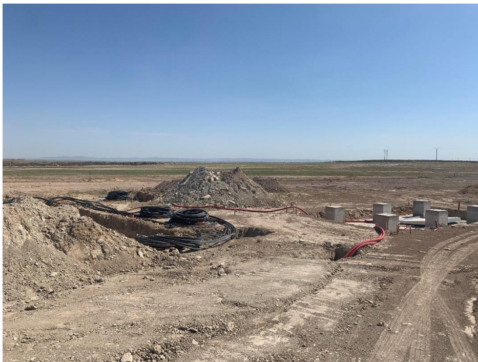
Figura 2 Apertura de zanjas
