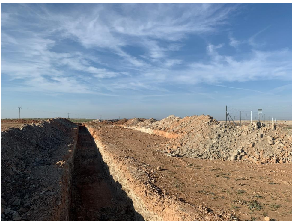
Figura 8 Apertura de zanjas
