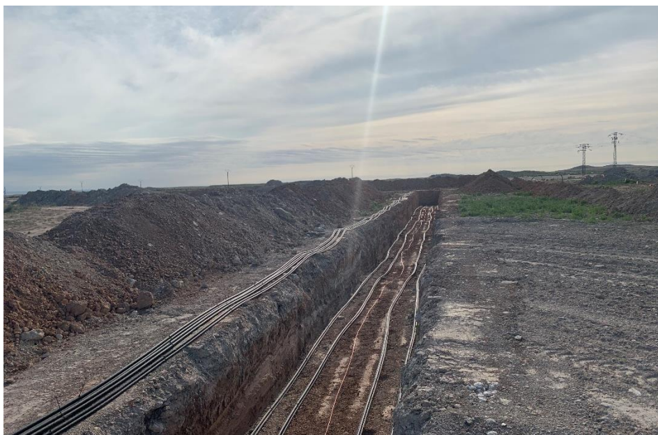
Figura 5 Cableado de zanjas
