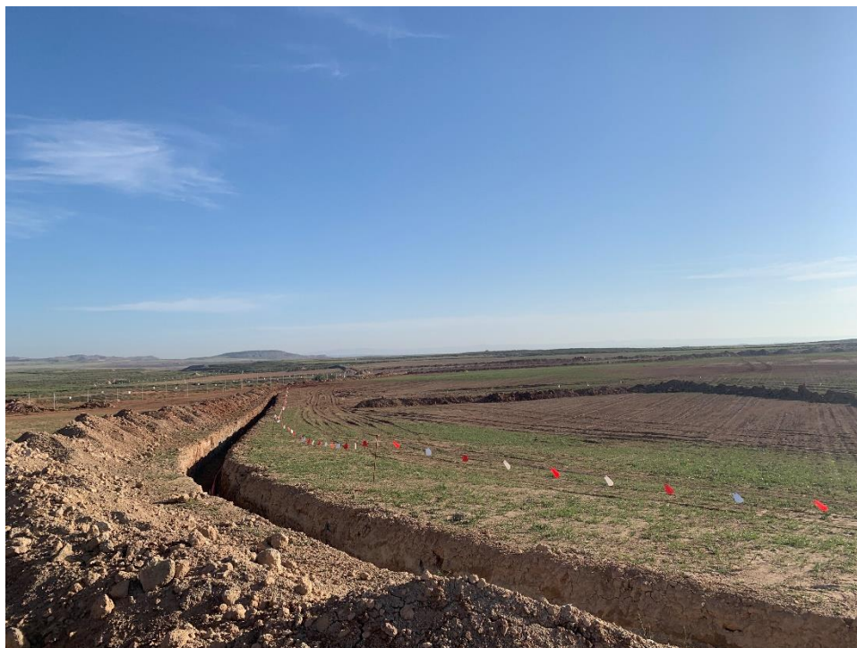
Figura 7 Apertura de zanjas
