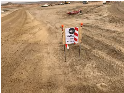
Figura 15 Señalización en obra
