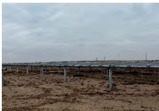
Figura 7 Montaje de los trackers
