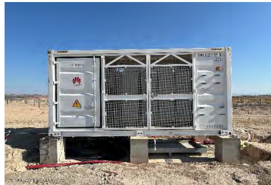
Figura 12 Cableado de los centros de transformación
