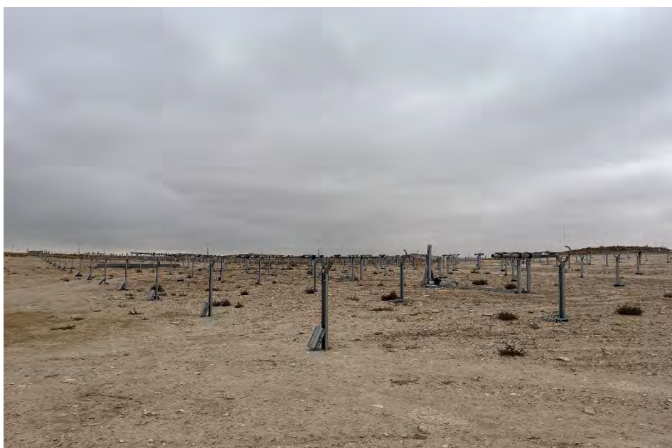
Figura 37 Labores de hincado
