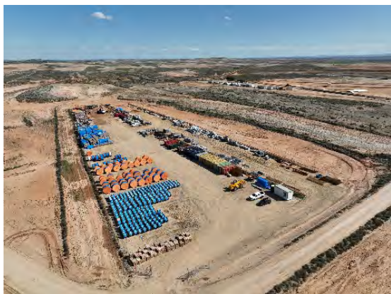
Figura 17 Zona de acopio del material de construcción
