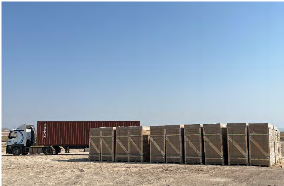
Figura 36 Acopio del material de construcción
