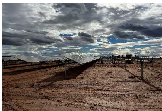
Figura 8 Montaje de los módulos fotovoltaicos
