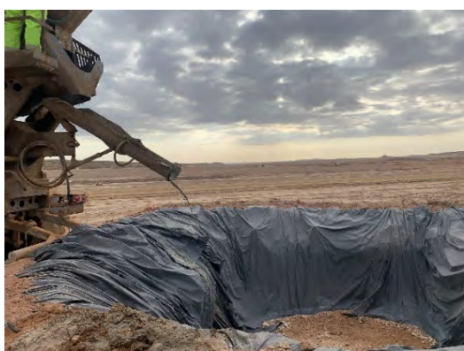
Figura 23 Lavadero de cubas de hormigón
