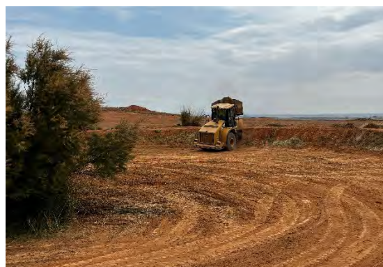
Figura 33 Restauración de los balsetes
