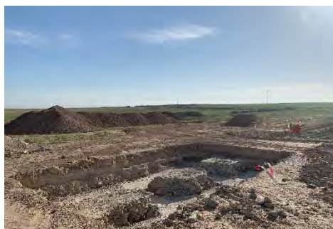
Figura 4 Trabajos de cimentación
