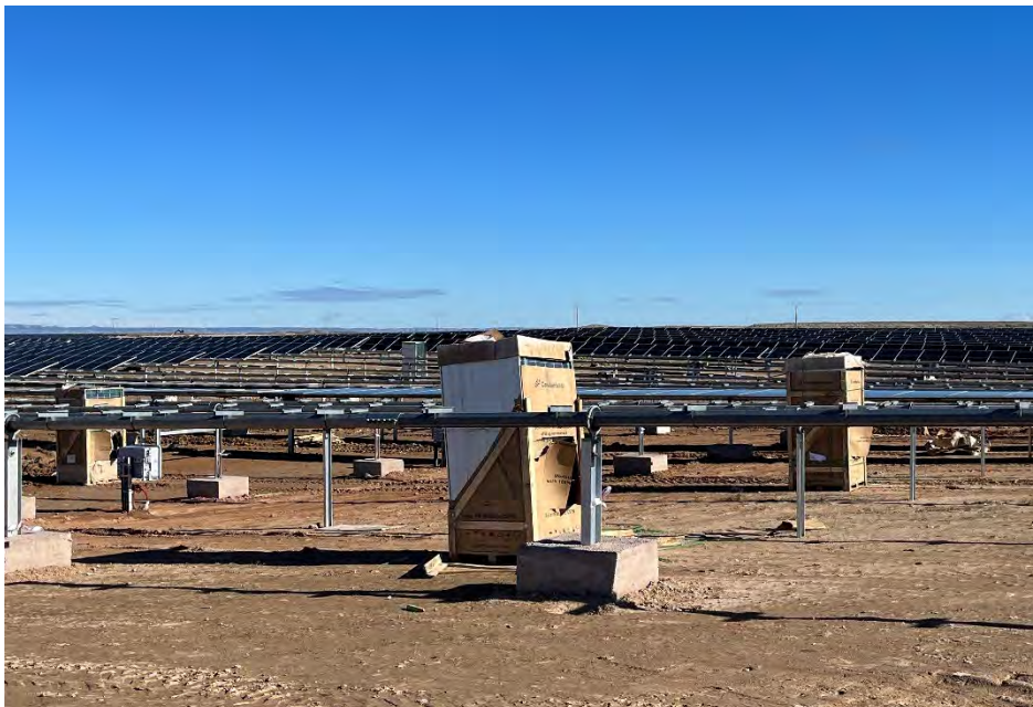
Figura 39 Montaje de los módulos
