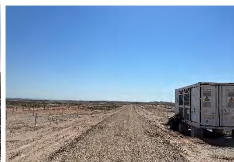
Figura 5 Apertura de viales
