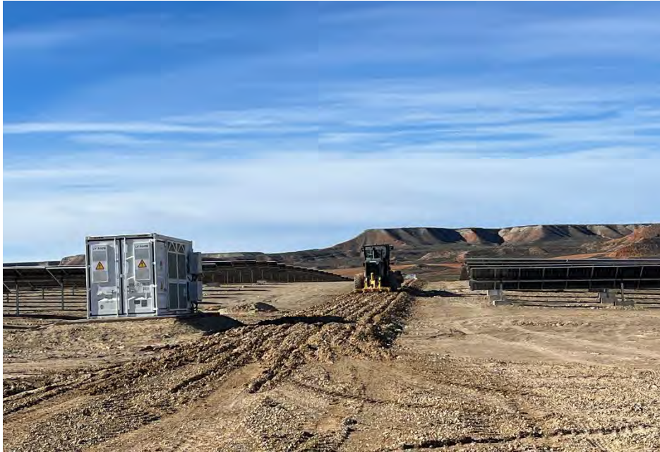
Figura 38 Restauración del vial interno
