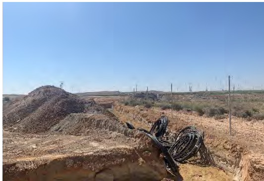
Figura 9 Tendido de cable de baja tensión
