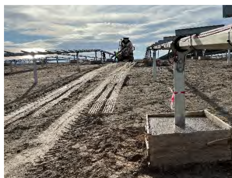
Figura 22 Trabajos de cimentación
