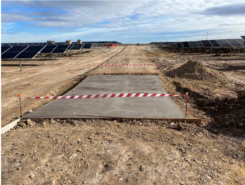
Figura 40 Cimentación del vial interno
