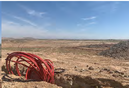
Figura 10 Tendido de cable de media tensión
