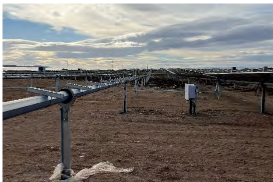
Figura 11 Montaje de los inversores
