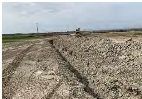
Figura 3 Apertura de zanjas
