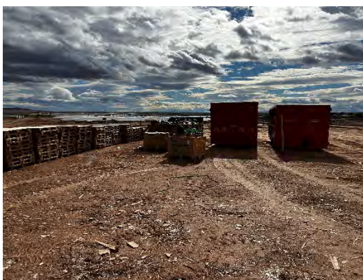
Figura 24 Punto limpio de residuos no peligrosos
