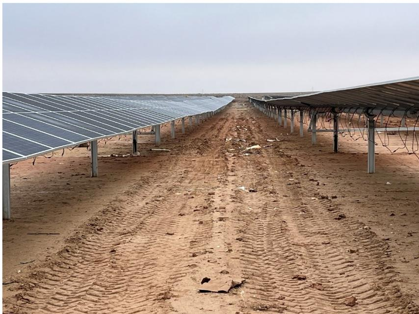
*Figura 3 Montaje de los módulos*
