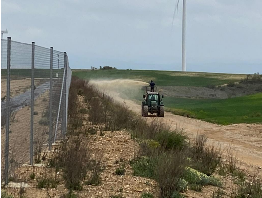
Imagen 3: Hidrosebradora extendiendo la mezcla sobre el talud exterior situado en el extremo Noreste de la planta fotovoltaica
