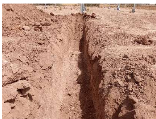
Fot. 1, 2, 3 y 4. Realización del zanjeado de BT en A1, A2 y A3 de PSFV Pitarco A Norte
