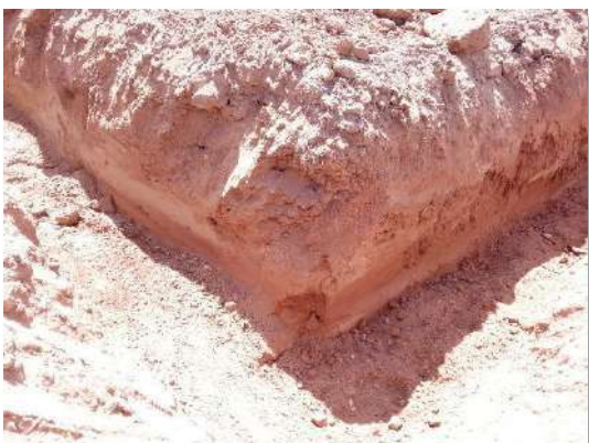
Fot. Apertura de las zanjas en PSFV Pitarco C.
