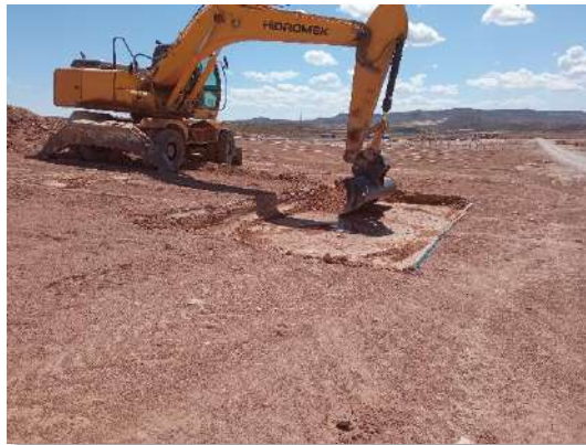
Movimiento de tierra en Pitarco A para plataforma.
