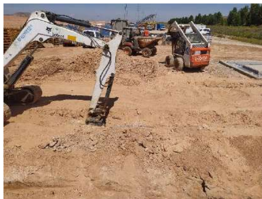
Fot. 1 y 2. Realización del zanjeado de Subestación junto a Campa en PSFV Pitarco A
