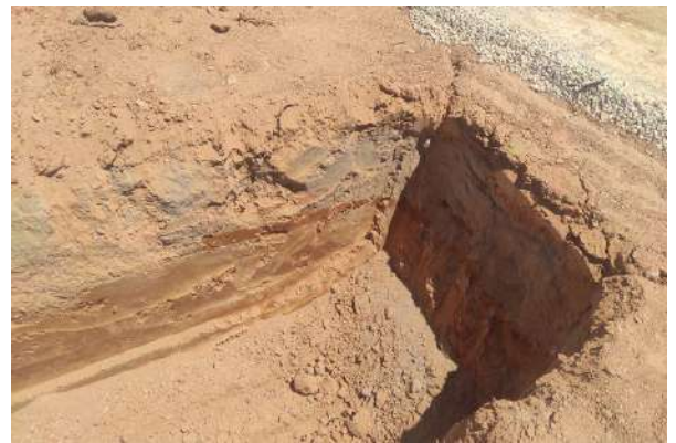
Fot 3 y 4. Zanja de MT en Pitarco C
