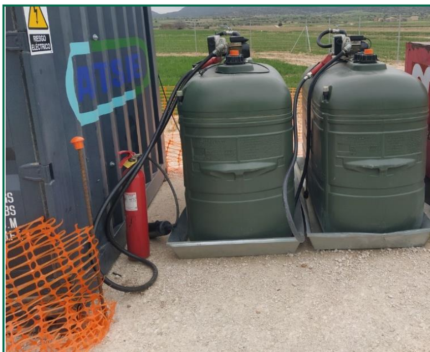
Fotografía 12. Extintor junto a contenedores de combustible.
