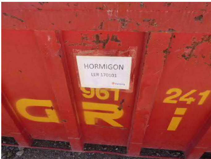
Imágenes 40 y 41: Etiquetado del contenedor del residuo no peligroso "hormigón" (fotos del lado izquierdo). Residuos en el interior del contenedor (fotos del lado derecho).
