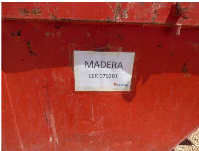
Imágenes 36 y 37: Etiquetado del contenedor del residuo no peligroso "madera" (fotos del lado izquierdo). Residuos en el interior del contenedor (fotos del lado derecho).
