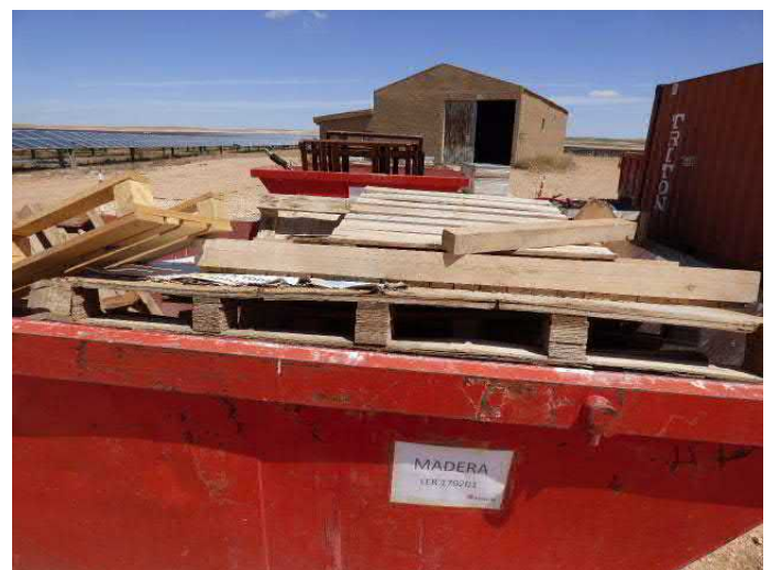
Imágenes 36 y 37: Etiquetado del contenedor del residuo no peligroso "madera" (fotos del lado izquierdo). Residuos en el interior del contenedor (fotos del lado derecho).
