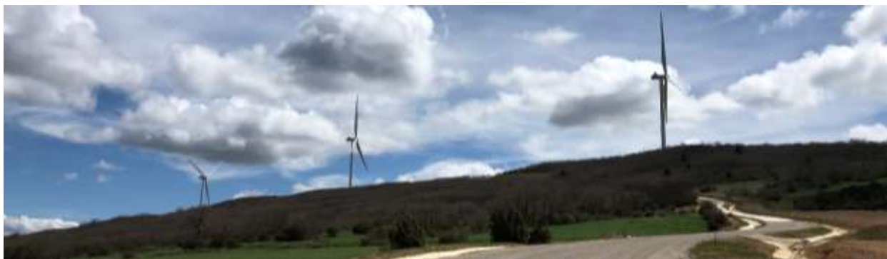
Figura 1: Vistas del parque eólico
