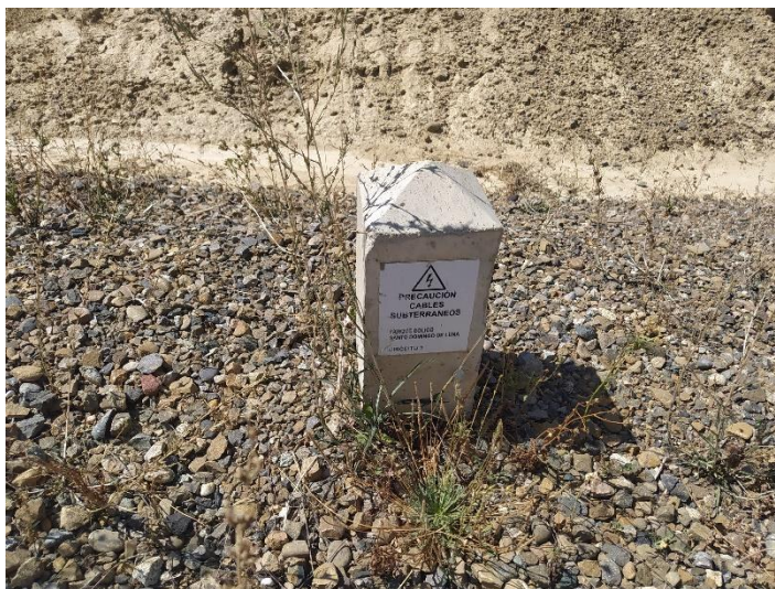
Fotos 17 y 18: Señalización de la línea eléctrica subterránea
