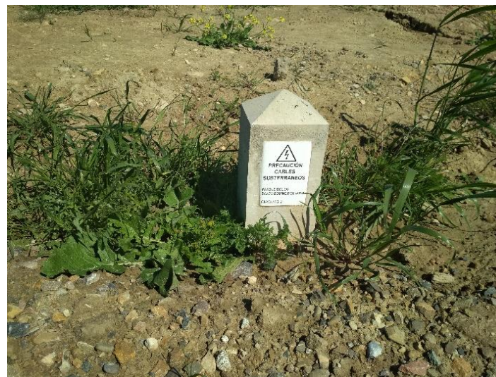
Fotos 17 y 18: Señalización de la línea eléctrica subterránea
