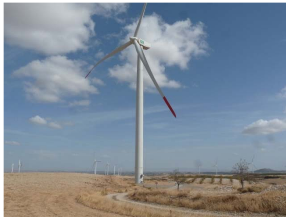
Foto 4. Visual aerogenerador SFB-02
