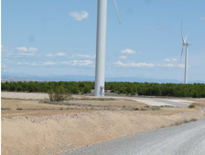
Foto 3. Pinares de repoblación y campos de cultivo representativos en la zona de implantación del parque eólico. SFB-05 y SFB-06 (al fondo)
