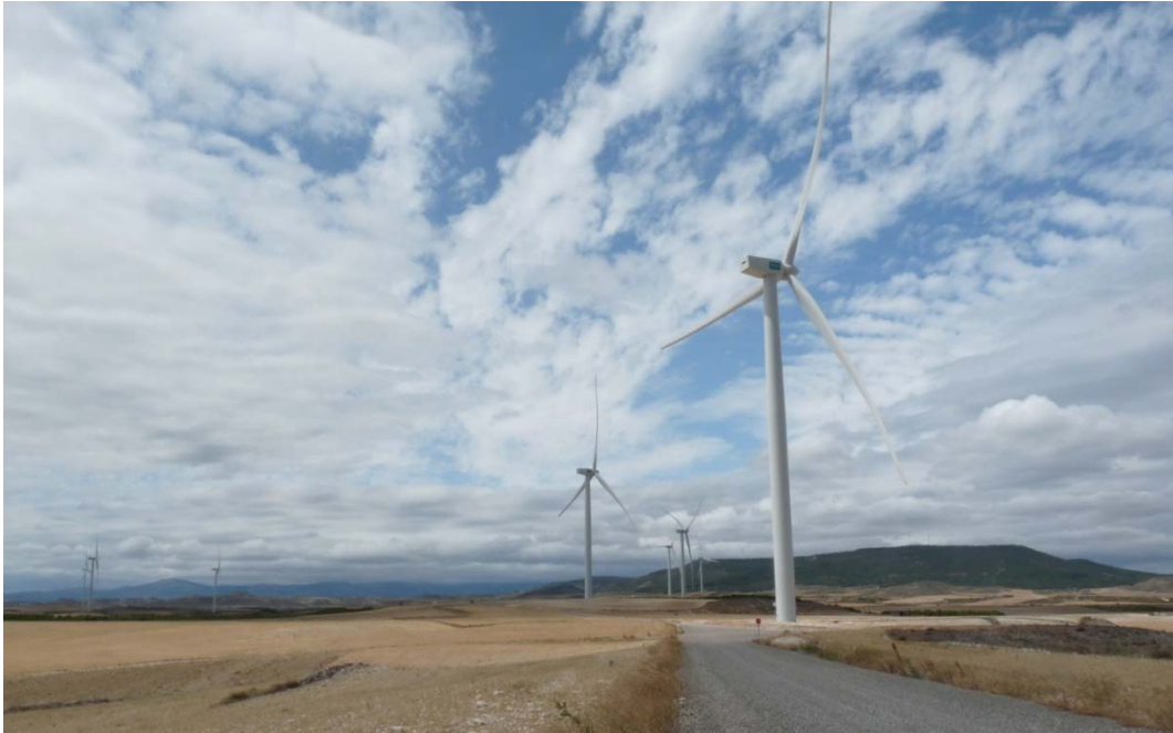
Aerogeneradores del 7 (primer plano) al 3
