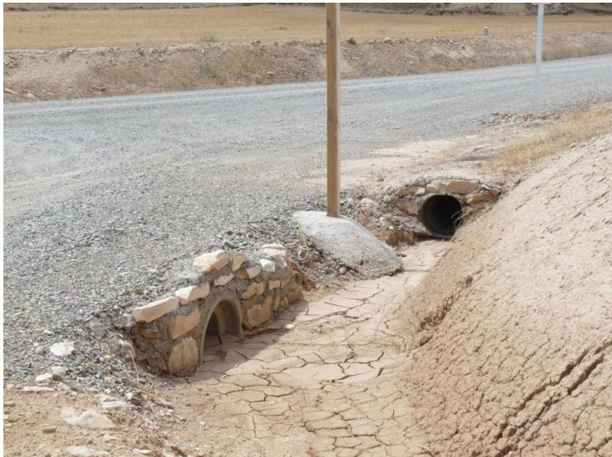
Foto 5. Drenaje en vial y paso en acceso a finca
