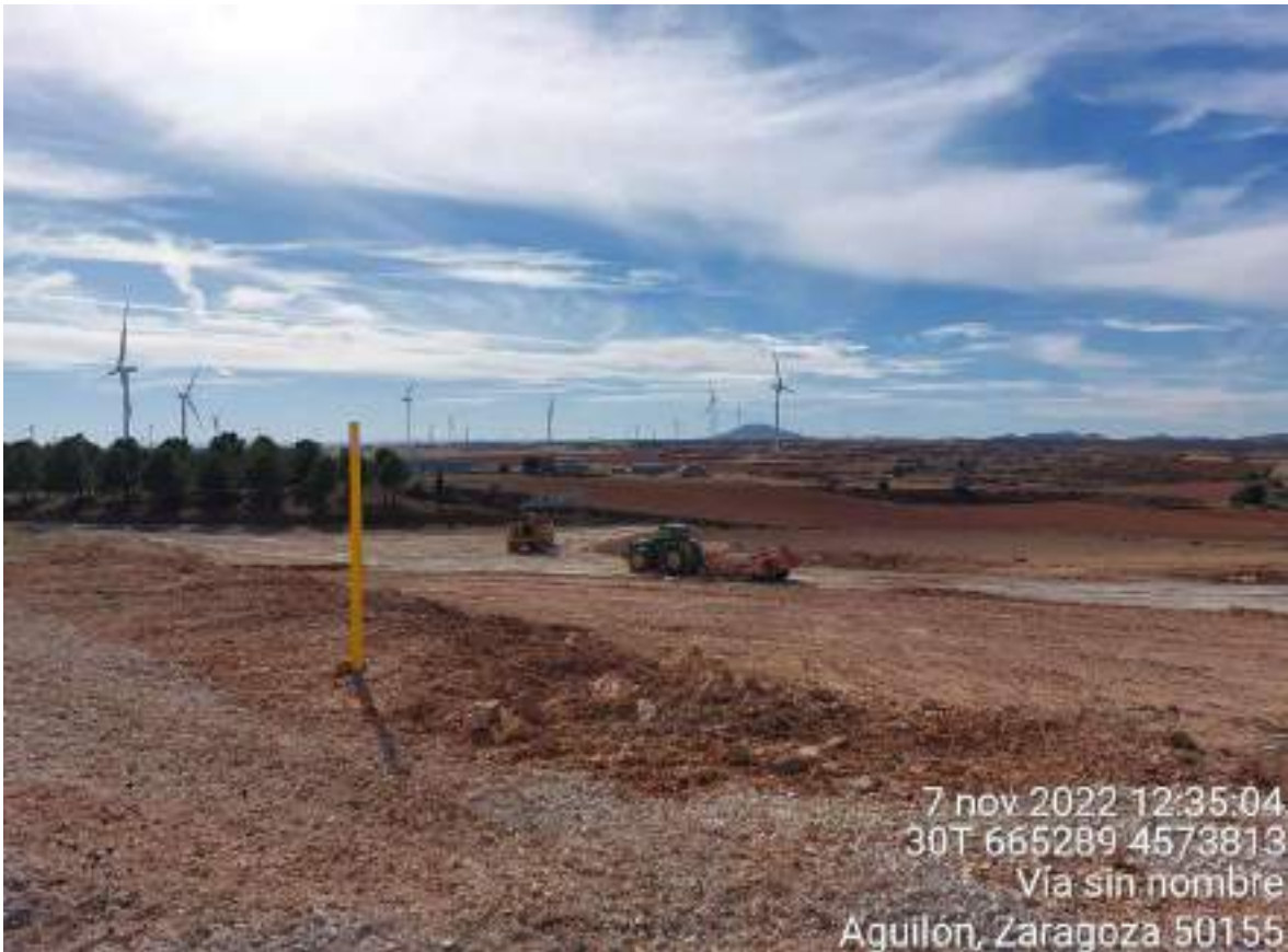
Imagen 5. Maquinaria realizando trabajos de restauración en la posición SBI-01
