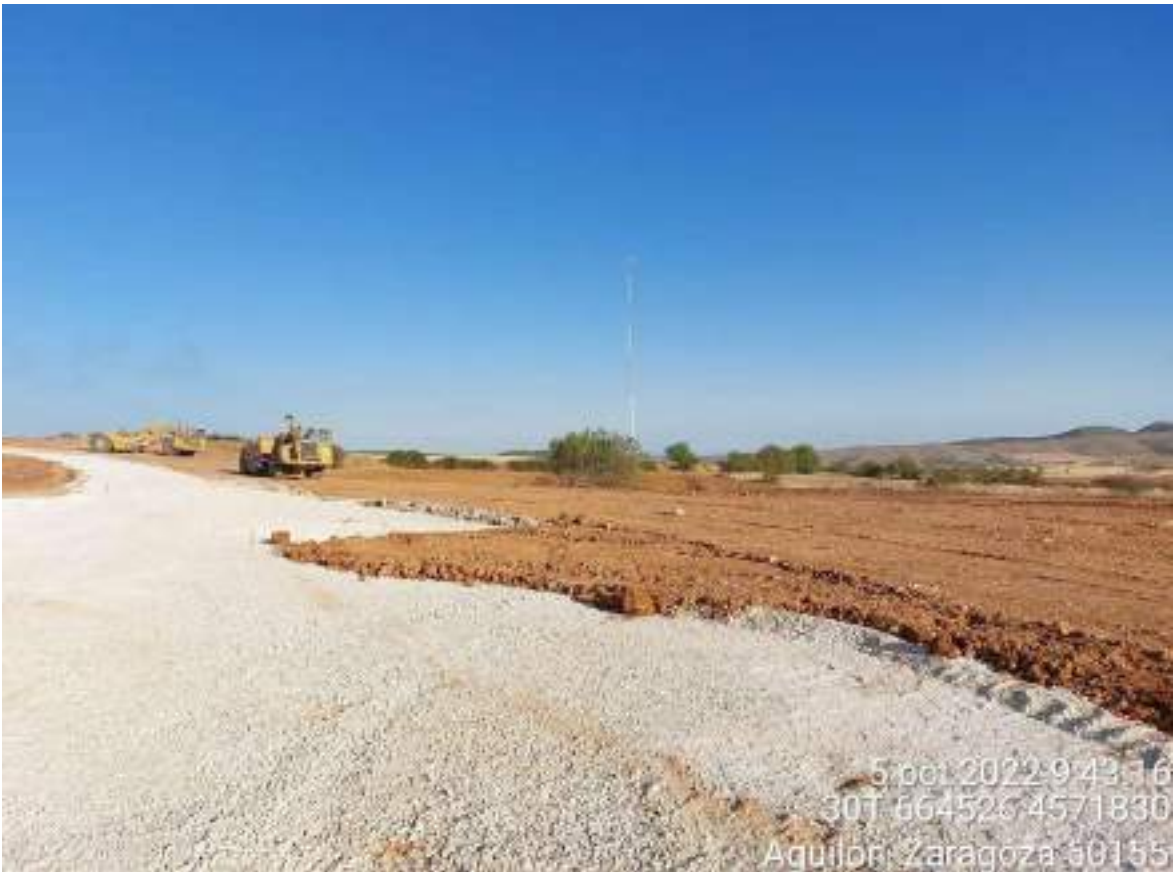
Imagen 3. Maquinaria realizando la restauración ambiental de SBII-03.
