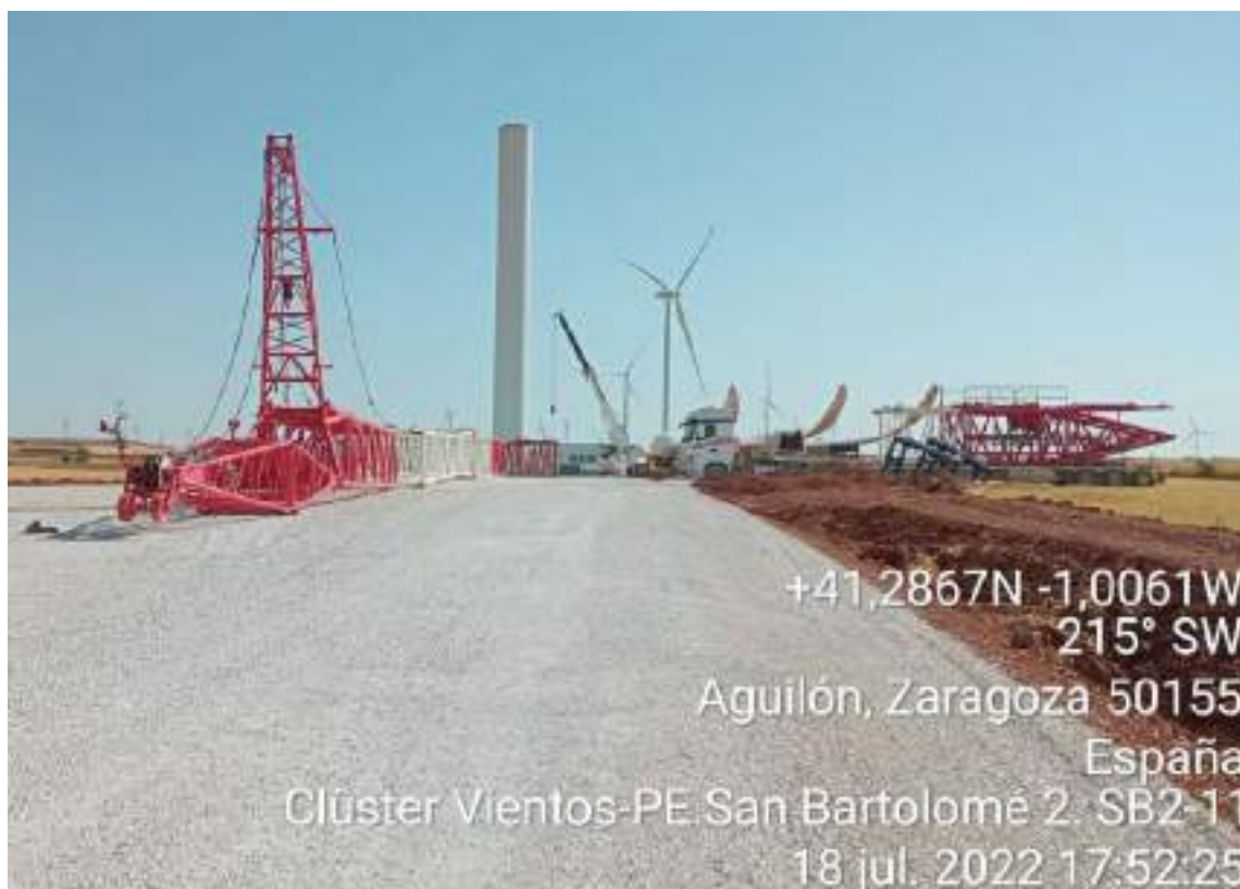
Imagen 2. Trabajos en plataforma de SB2-11
