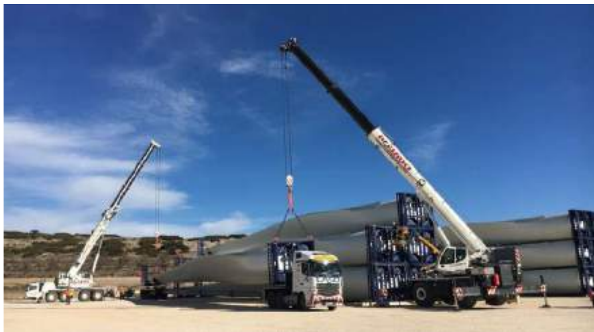
Imagen 5. Zona de acopio de material
