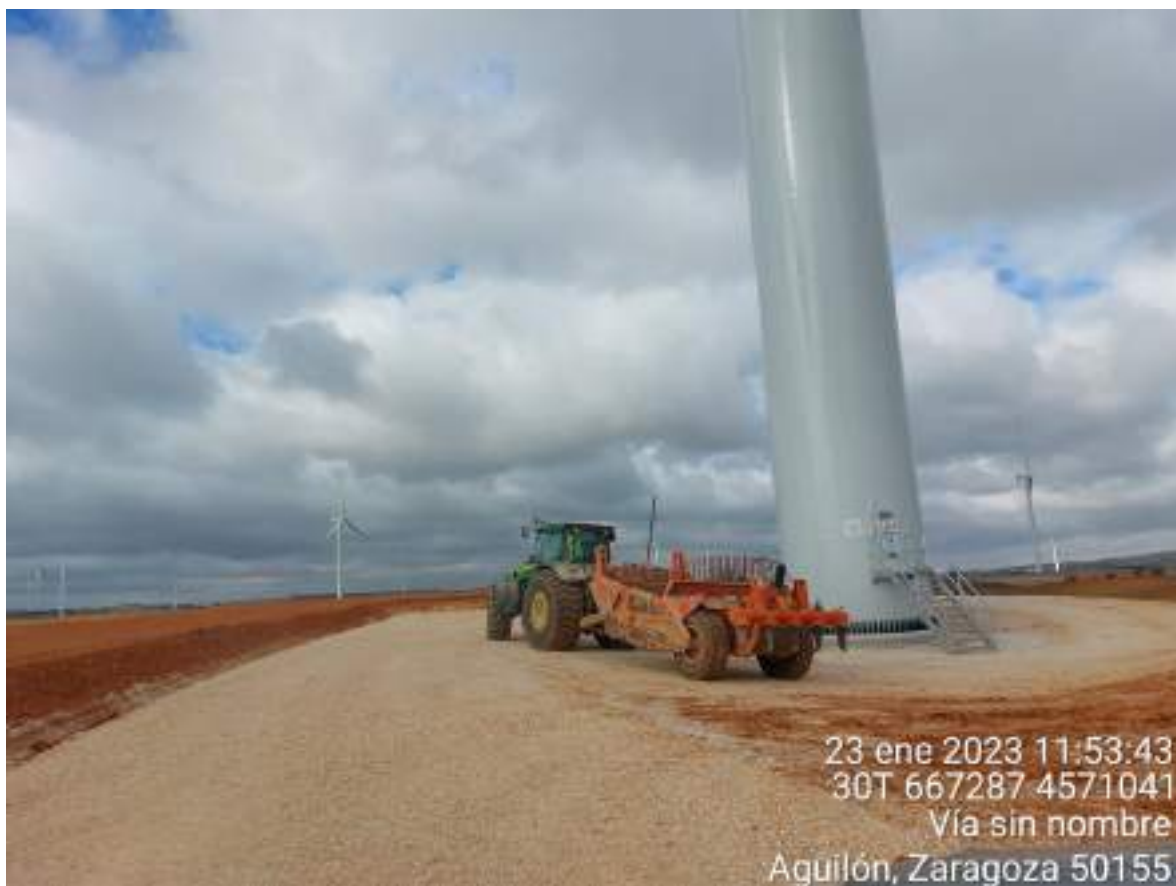
Imagen 2. Maquinaria realizando trabajos de restauración en PLX-02
