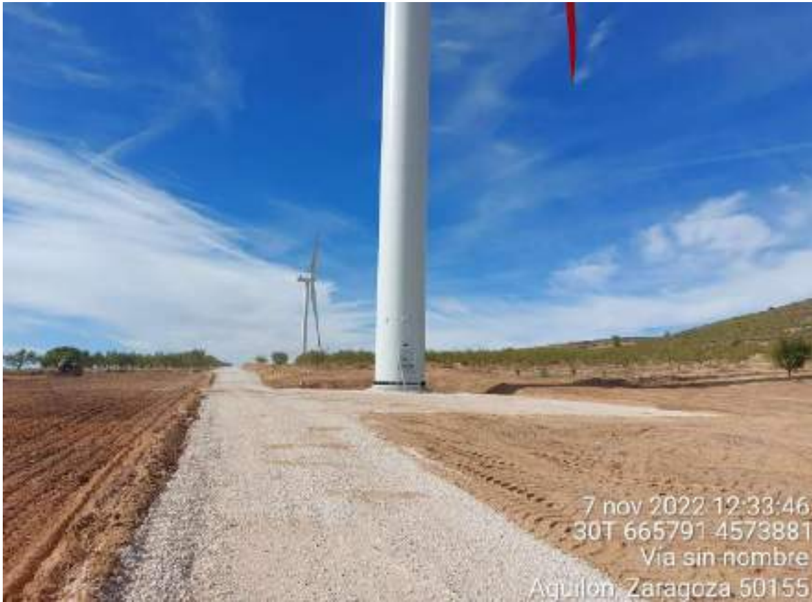
Imagen 4. Posición SBI-02 durante su restauración.
