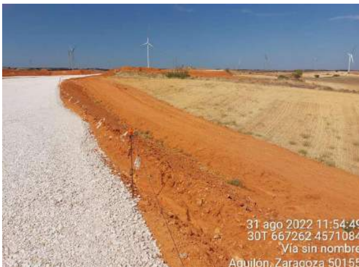
Imagen 1. Posición PLX-02 durante la visita de restauración.
