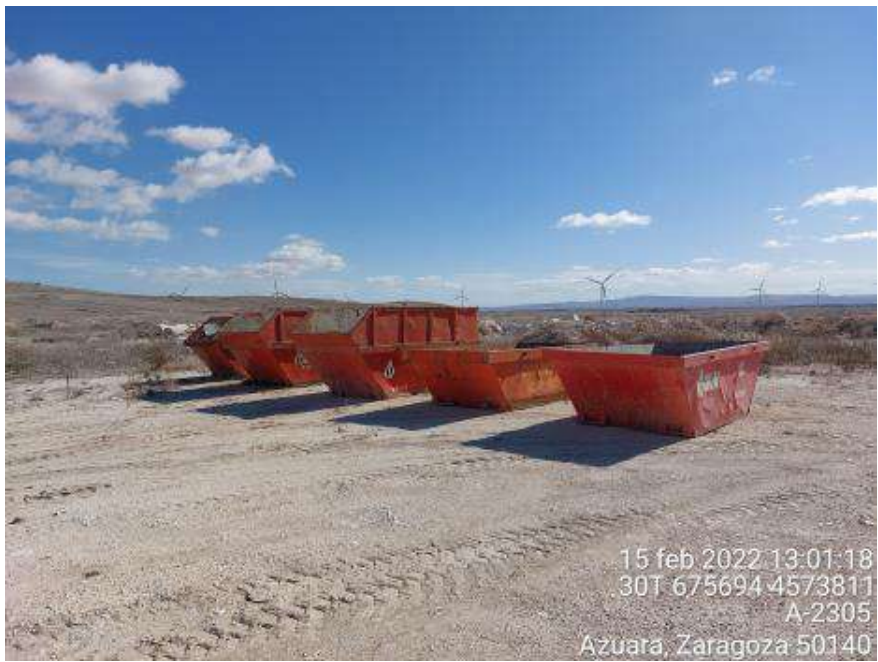
Imagen 6. Punto limpio. Contenedores de residuo no peligroso
