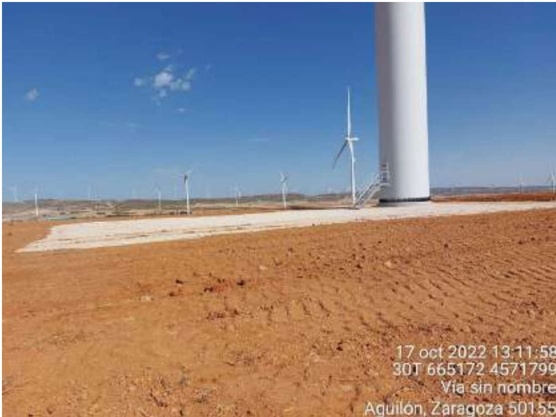
Imagen 1. Plataforma SBII-05 tras su restauración ambiental.
