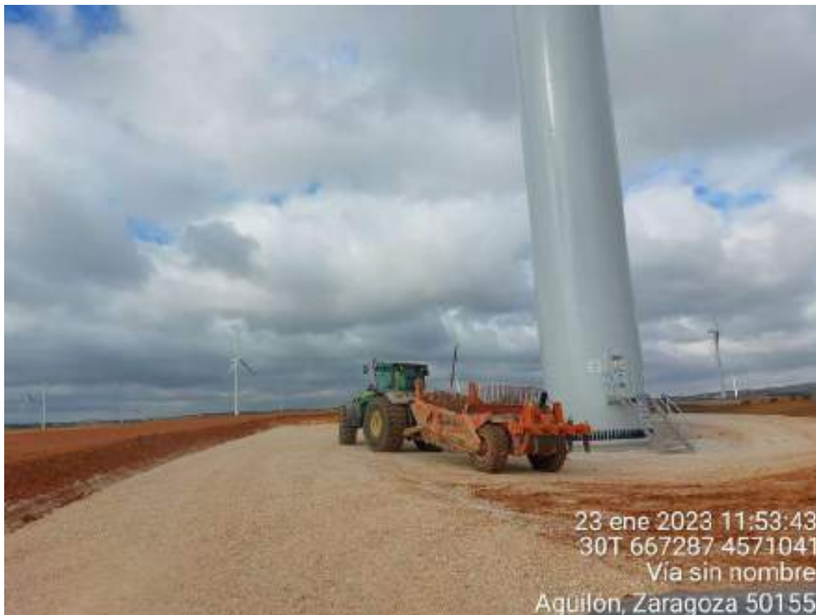
Imagen 2. Maquinaria realizando trabajos de restauración en PLX-02
