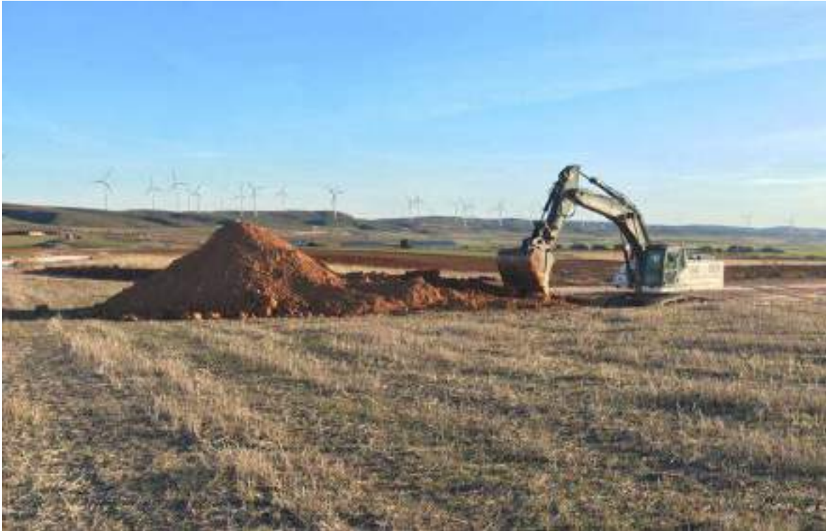
Imagen 1. Retroexcavadora trabajando en SBII-02
