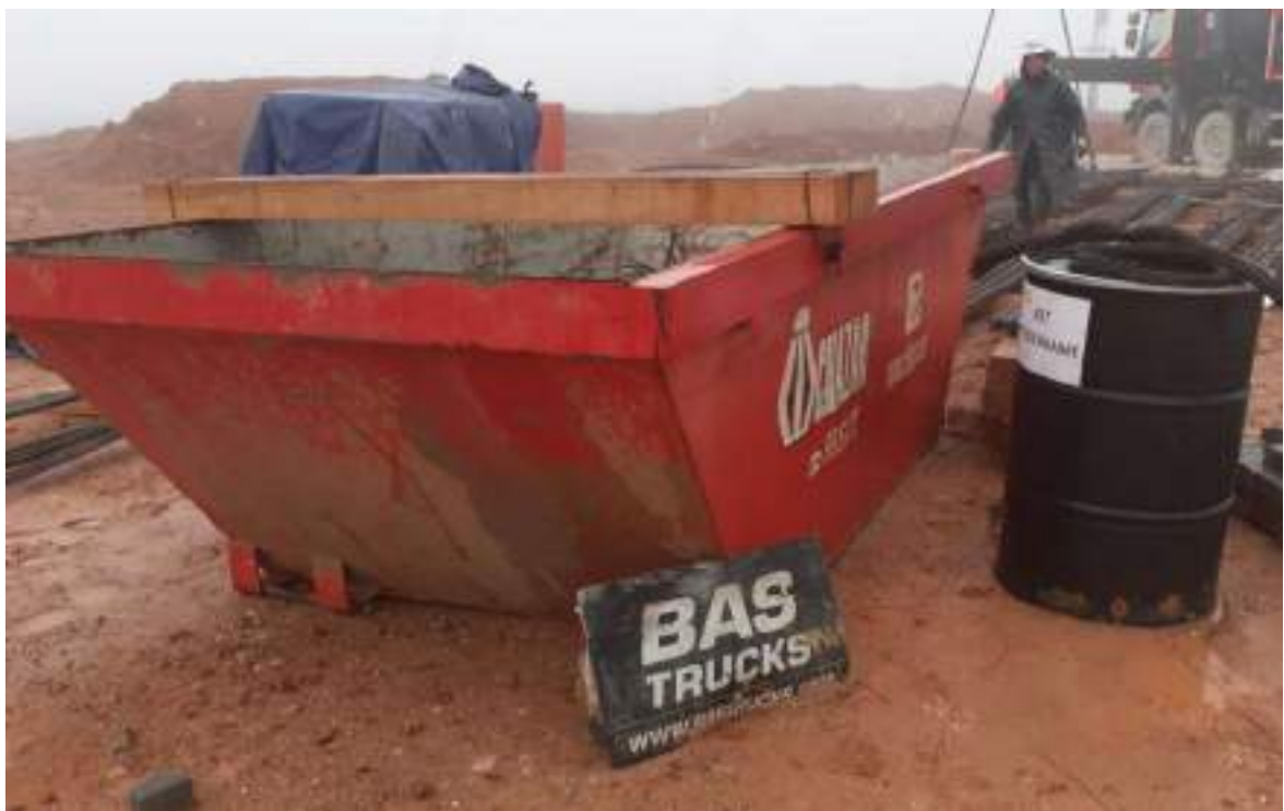
Imagen 2. Contenedor portátil para residuos en obra y kit antiderrame en SBII-03.
