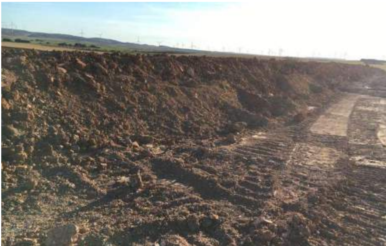
Imagen 4. Acopio de tierra vegetal en SBII-02
