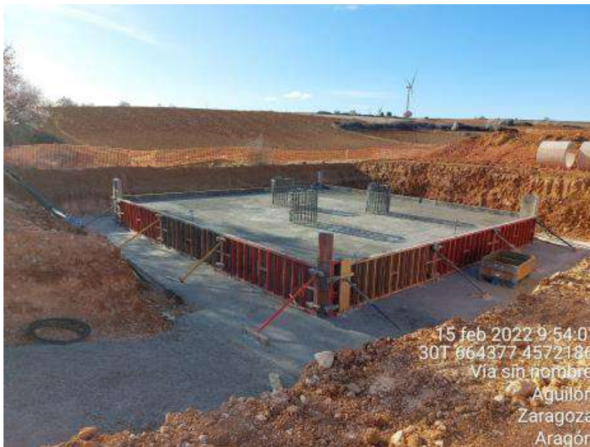
Imagen 4. Hormigonado de la torre de medición
