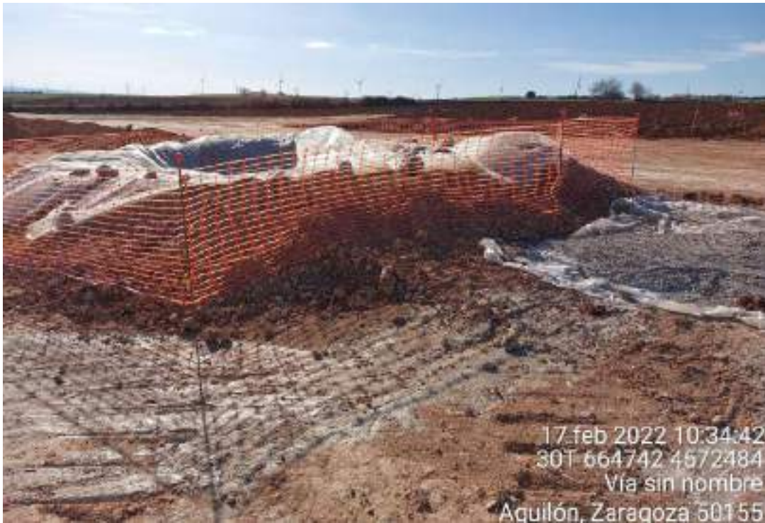
Imagen 2. Zona de lavado en SBII-02
