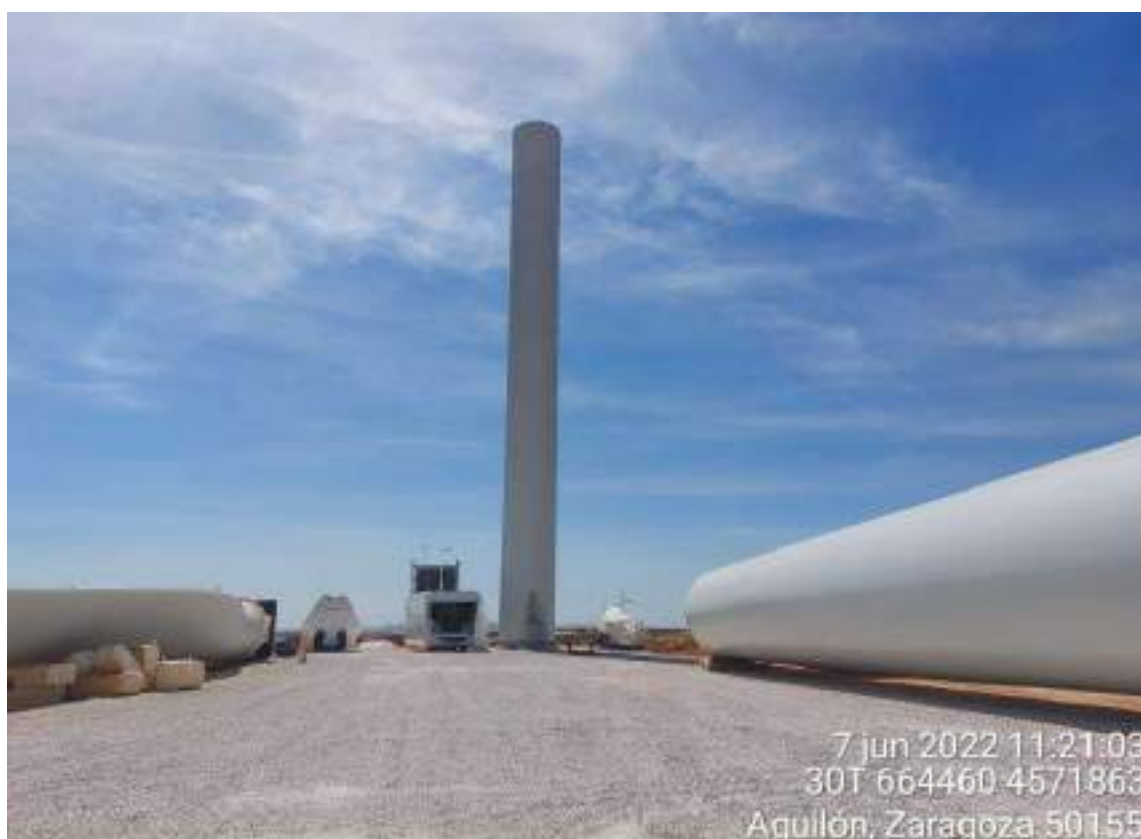
Imagen 1. Montaje del aerogenerador
