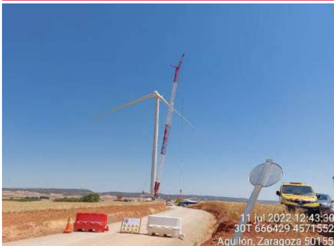
Imagen 1. Montaje del aerogenerador SBII-10.
