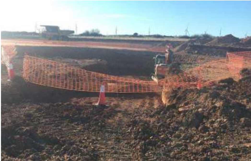
Imagen 2. Excavación zapata SBII-02
