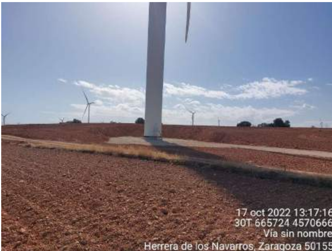
Imagen 2. Plataforma SBII-08 tras su restauración ambiental.
