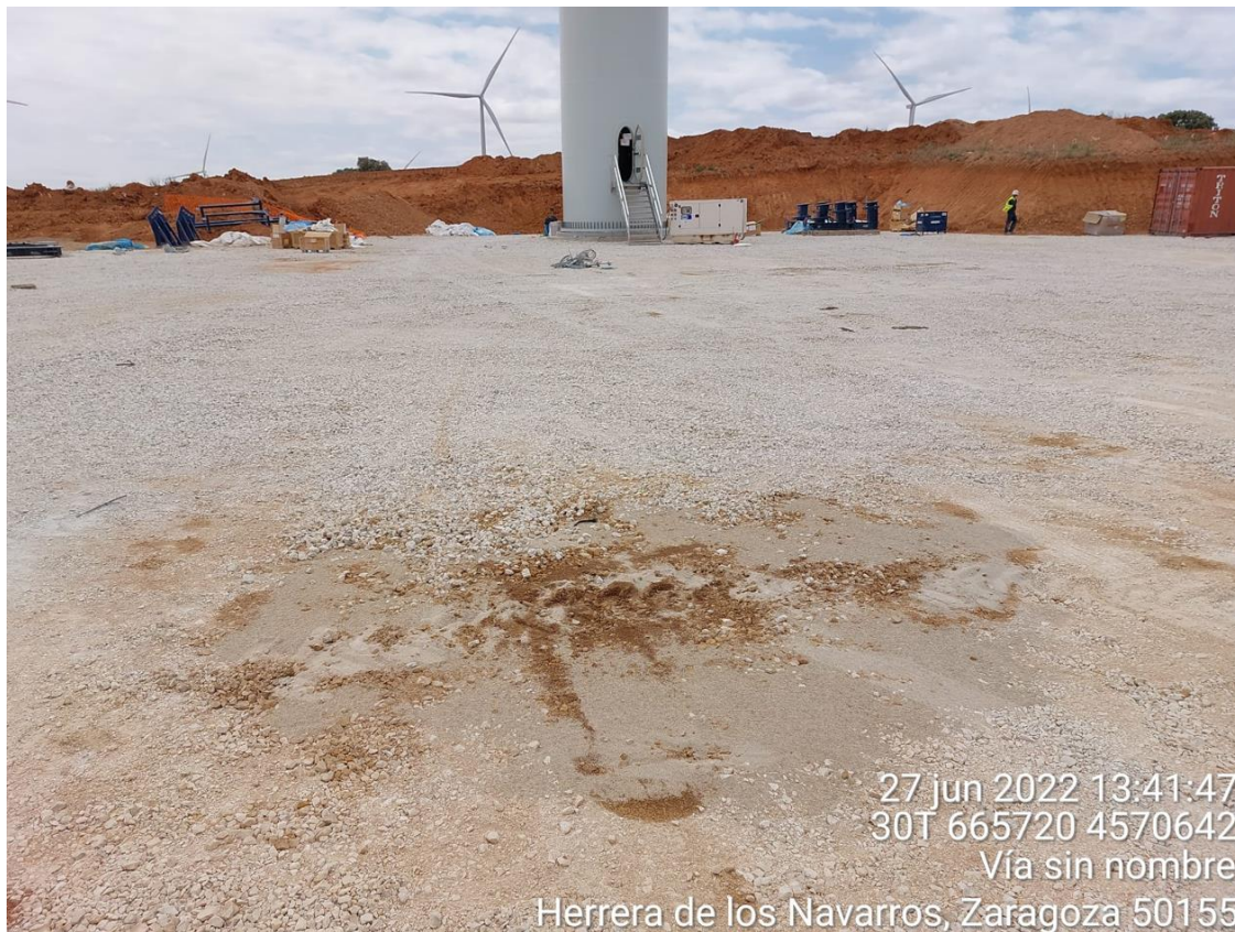
Imagen 2. Sepiolita aplicada para corregir mancha de aceite en zahorra de SBII-08.
