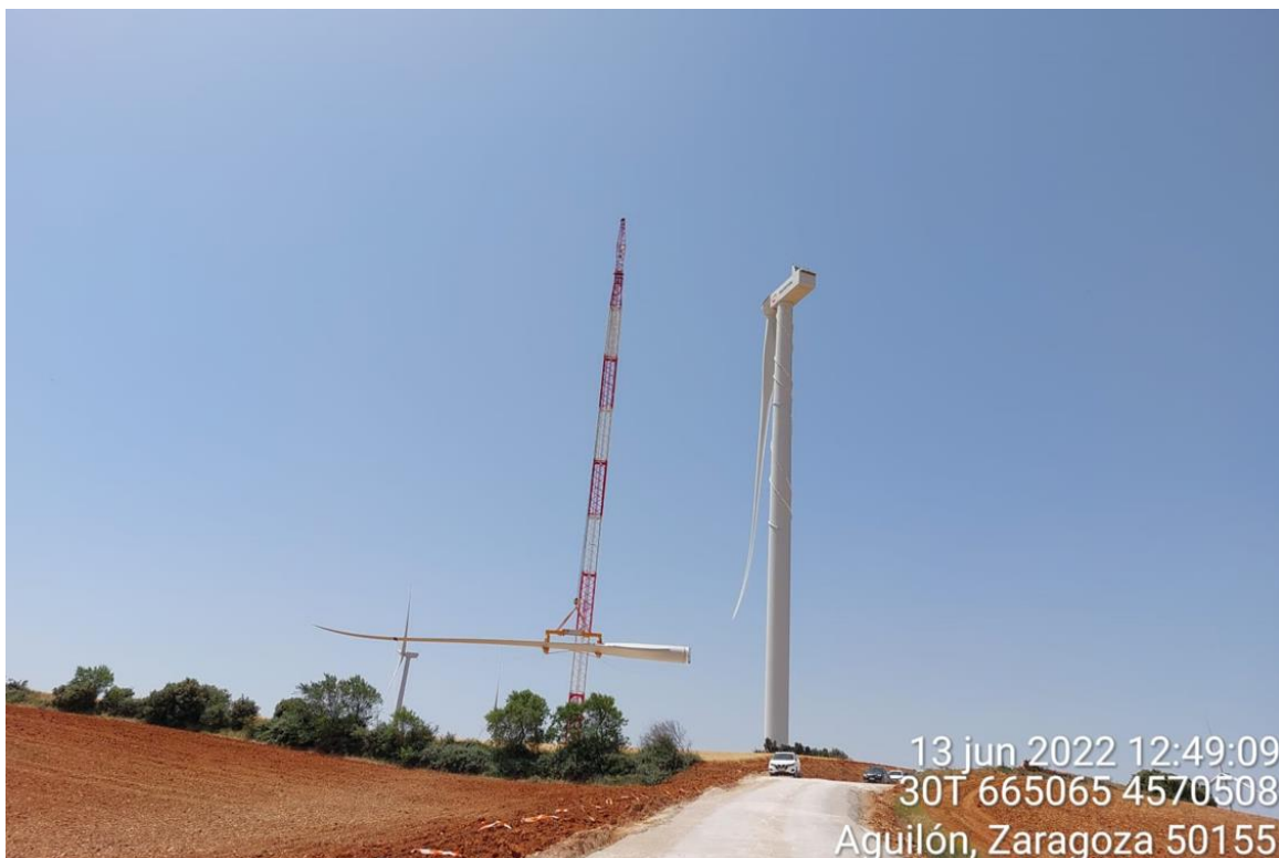
Imagen 3. Montaje del aerogenerador SB2-07.
