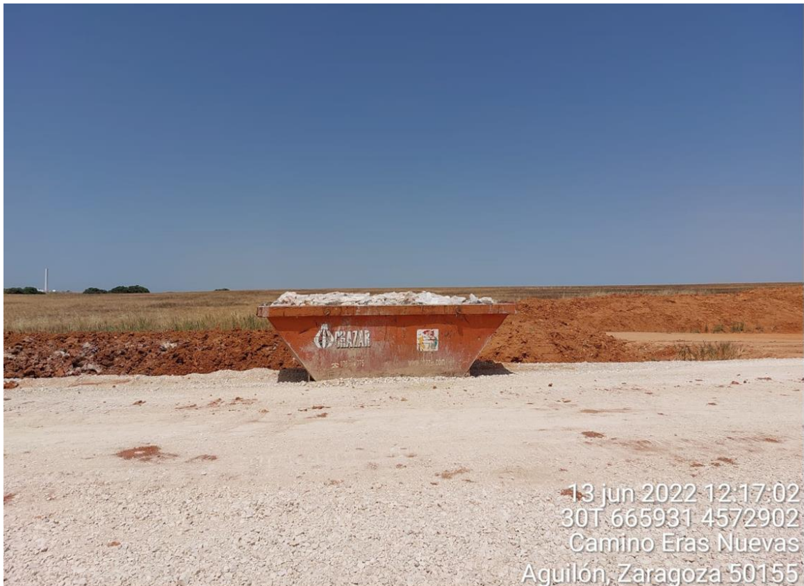
Imagen 2. Residuo de hormigón gestionado tras restaurar pozo de lavado.
