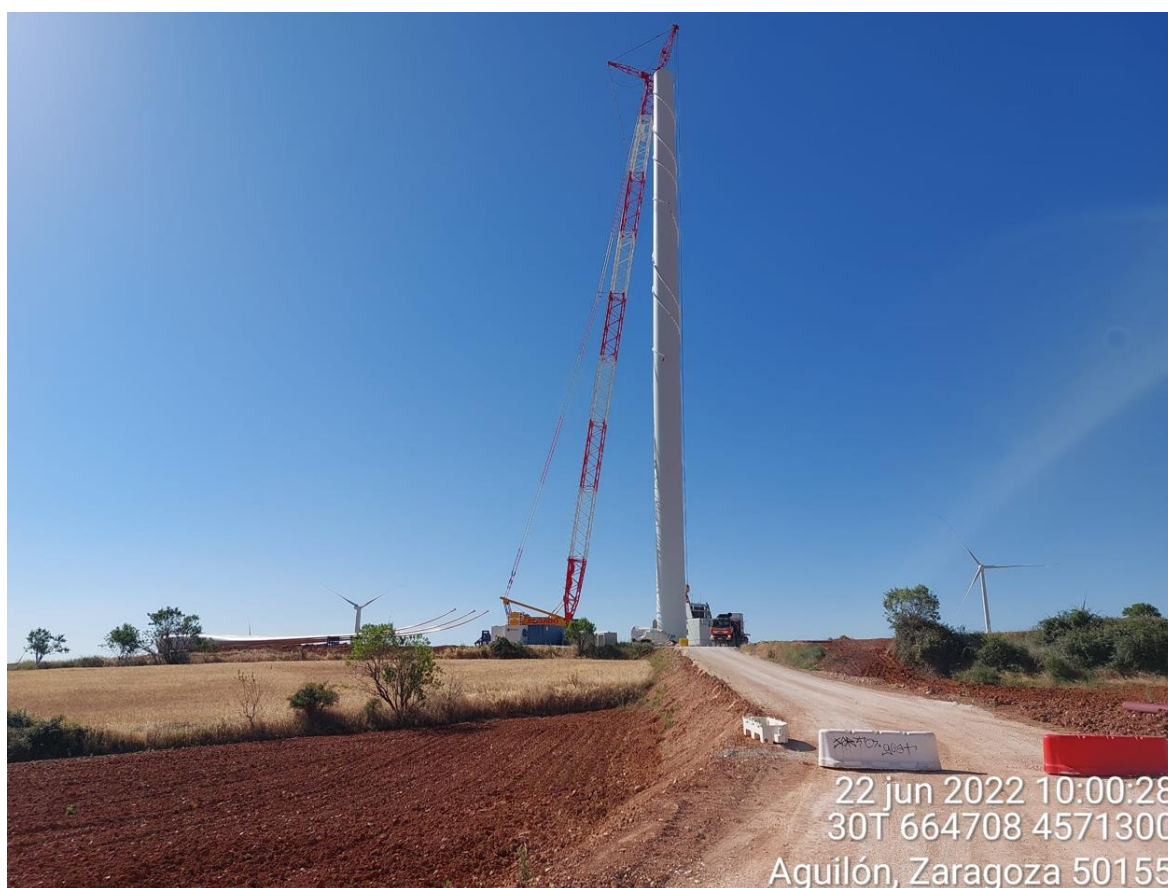
Imagen 1. Montaje de un aerogenerador
