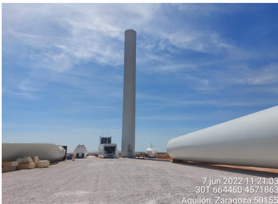
Imagen 1. Montaje del aerogenerador
