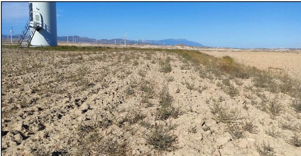
Fotografía 7. Plataforma junto a la turbina HE04
