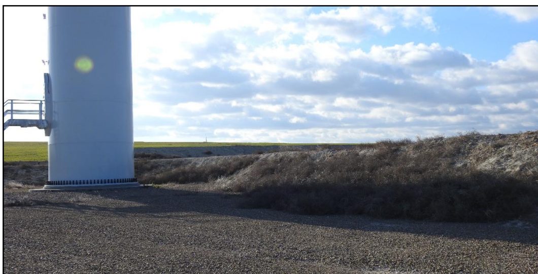
Fotografía 5. Vegetación sobre el talud de la turbina HE03.
