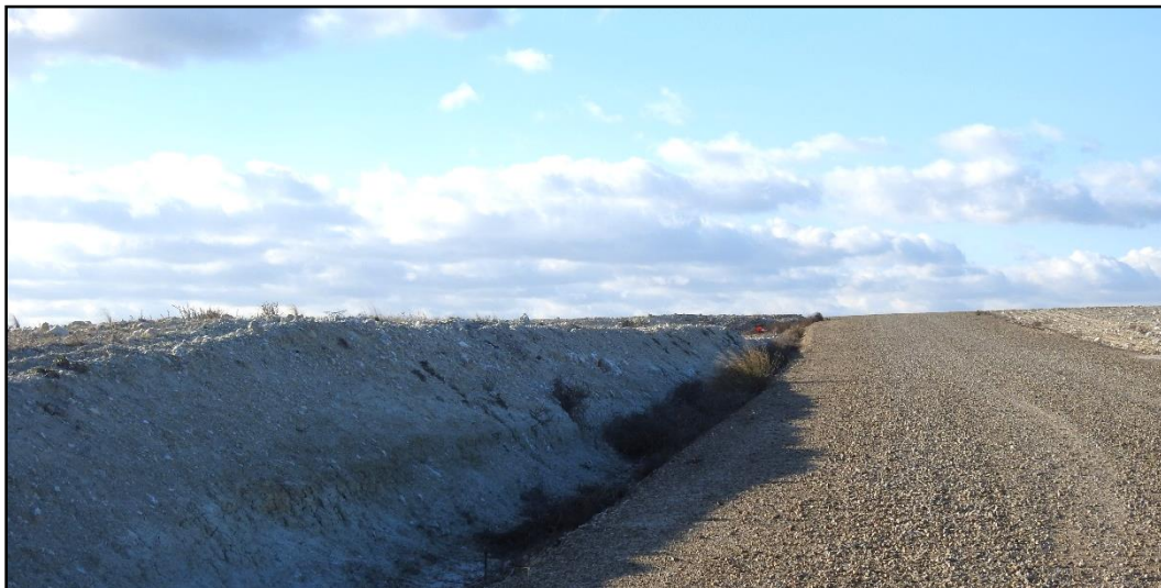
Fotografía 3. Desmonte en el acceso al aerogenerador HE-01.
