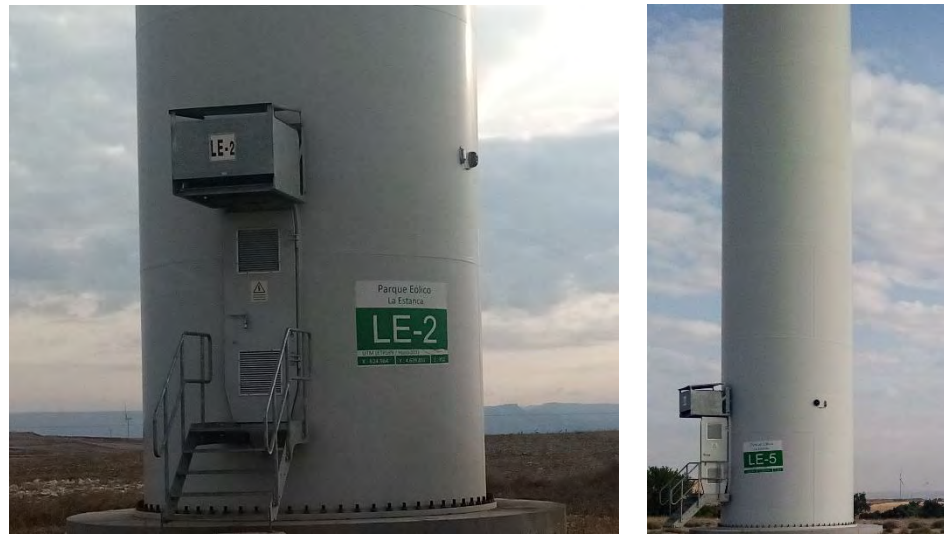
Fotografías 7 y 8: Señalización torres aerogeneradores
