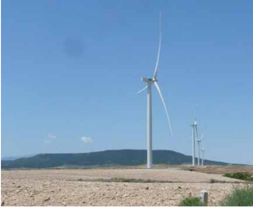
Aerogeneradores La Estanca del 1 al 4 (primer plano)
