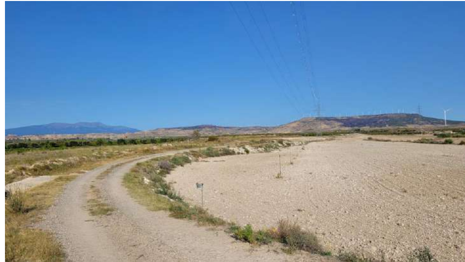
Fotografías 10 a 12: Estado de caminos y viales
