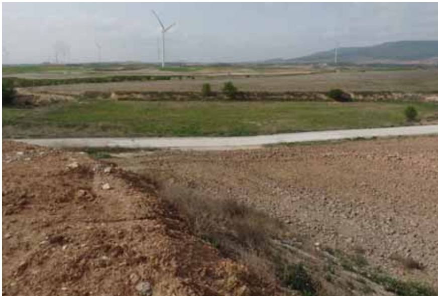
Foto 4. Vado en vial para permitir la evacuación del agua de lluvia.
