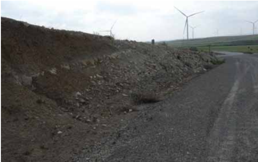
Foto 5. Cuneta en la plataforma y vial de acceso
