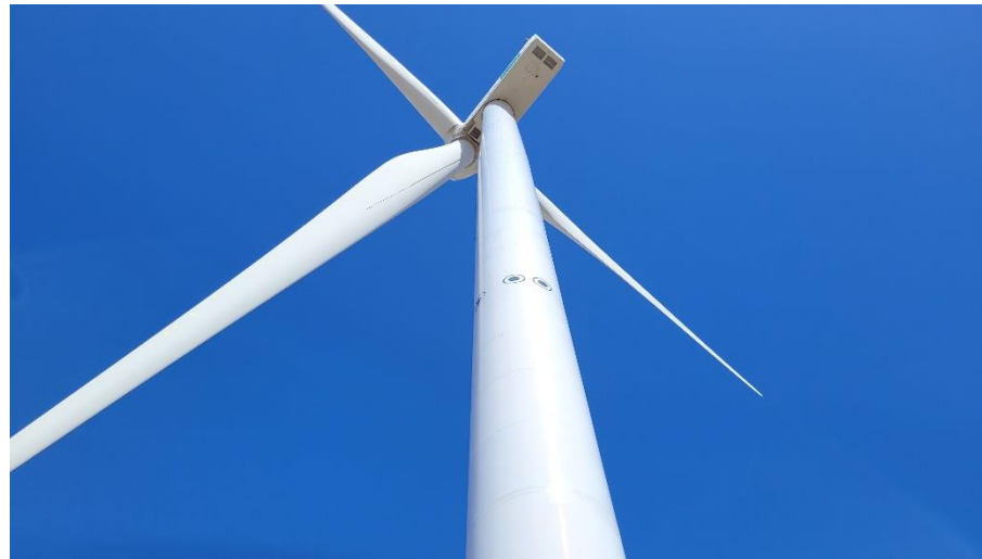
Fotografía 3: Barquillas de los aerogeneradores sin derrames de aceite
