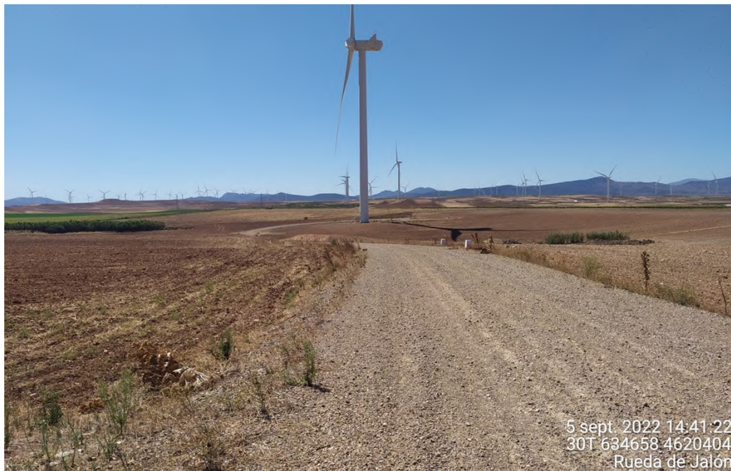
Figura 33: Taludes del vial acceso entre ELL1 y ELL2 con vegetación natural espontánea.
