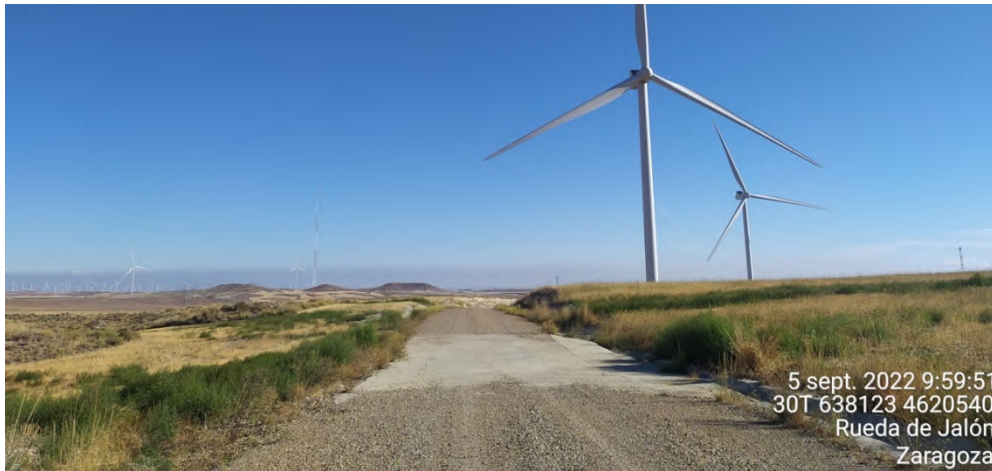
Figura 22: Vial de acceso a aerogeneradores ELL13 y 14, con badén inundable en buen estado.
