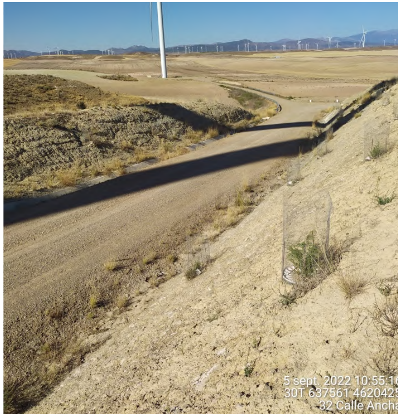
Figura 25: Fotografías de especies arbustivas plantadas artificialmente creciendo en taludes del vial entre ELL11 y ELL10, junto con especies xerófilas naturales surgidas espontáneamente.
