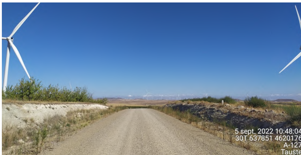
Figura 24: Vial de acceso entre aerogeneradores ELL9 y ELL10.
