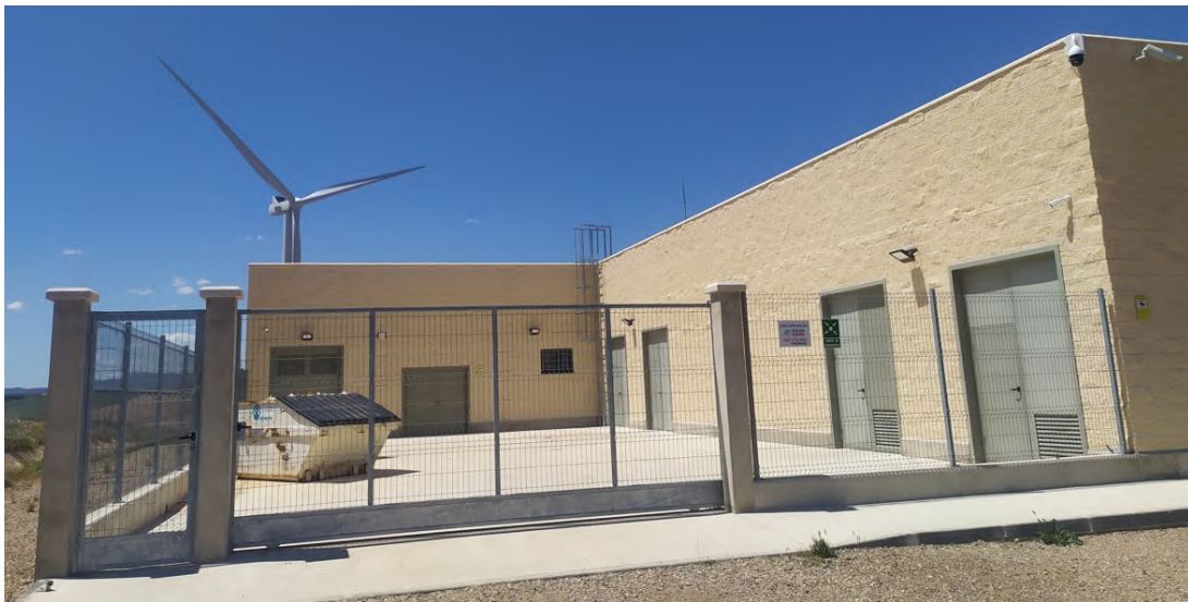
Figura 34: Almacén del PE El Llano, localizado al N del aerogenerador ELL10.
