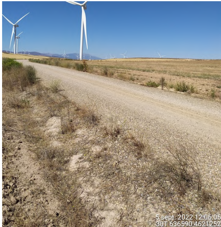
Figura 27: Vial de acceso entre aerogeneradores ELL7 y ELL8.
