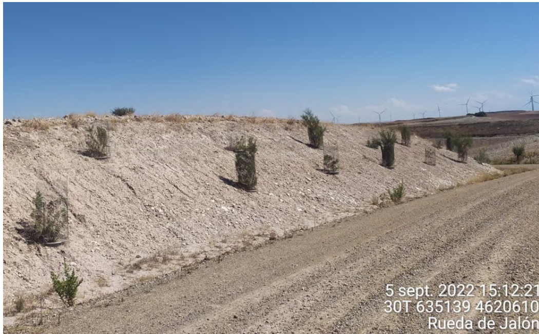
Figura 32: Otra sección de la rampa del vial entre ELL-4 y ELL3 mostrando especies arbustivas plantadas artificialmente en sus taludes.
