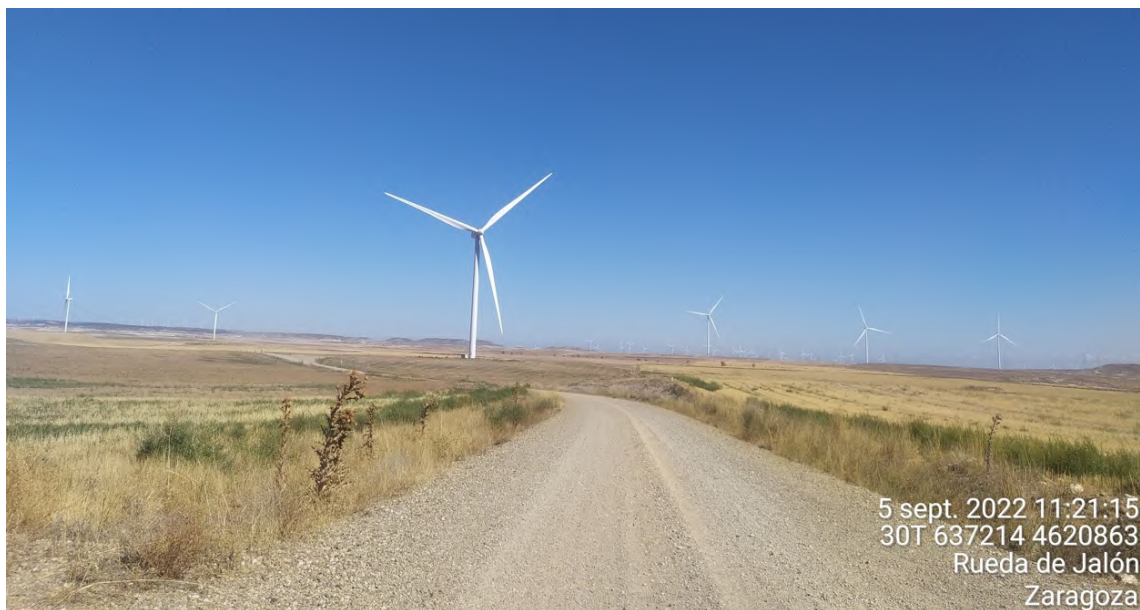
Figura 26: Vial de acceso entre aerogeneradores ELL10 y ELL9. A su derecha se ubica el campo de cultivo restaurado donde se localizó el Site Campo de Obra.
