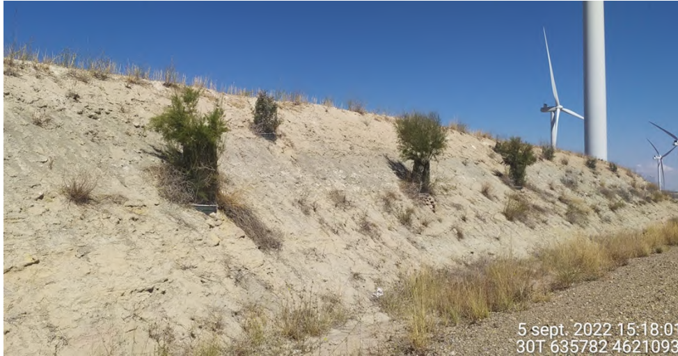
Figura 29: Otra fotografía de algunas especies arbustivas sembradas artificialmente con mayor grado de crecimiento en el talud del vial entre ELL-5 y ELL-6.
