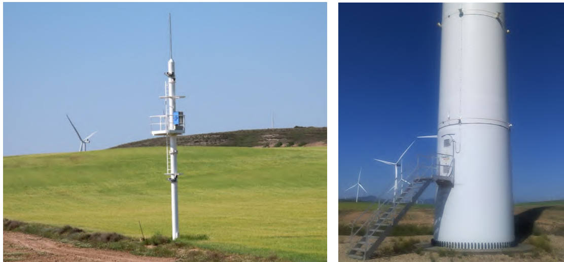
Figura 5: Fotografías del Sistema “3D Observer” ubicado junto al aerogenerador LLo7 (izquierda) y del Sistema “DTBird” instalado en el aerogenerador LLo8 (derecha).
