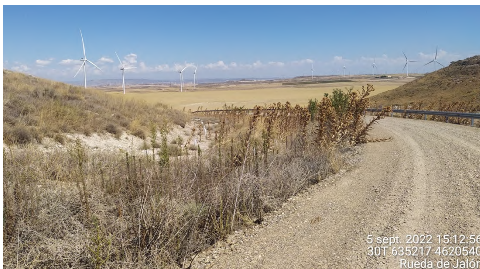
Figura 31: Curva en pendiente del vial de acceso entre ELL4 y ELL3 donde se realizó una plantación artificial. Se observa vegetación espontánea creciendo junto a la plantación.
