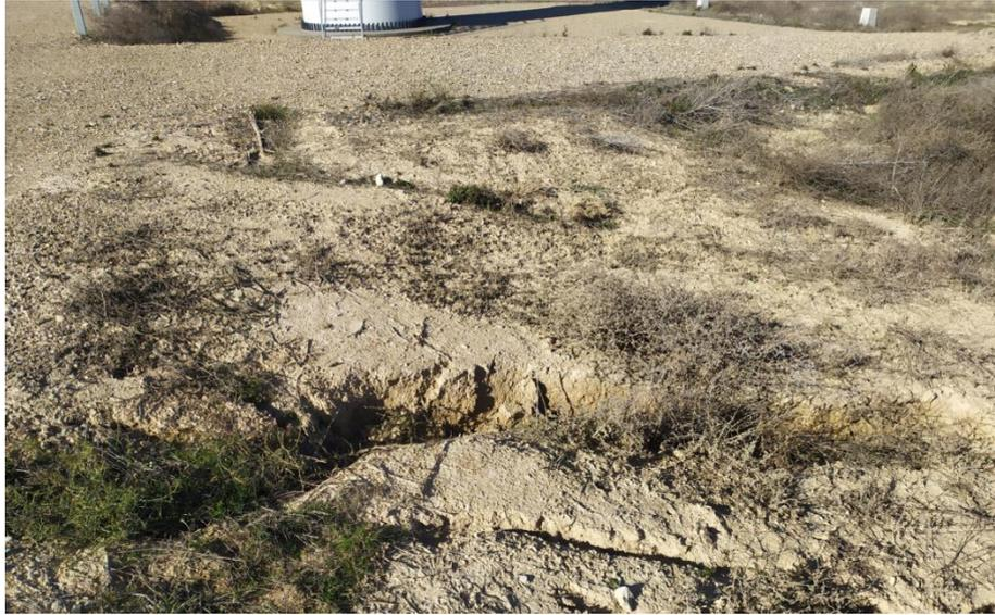
Figura 34: Erosión del terreno en los límites de la plataforma del aerogenerador ELL14.
