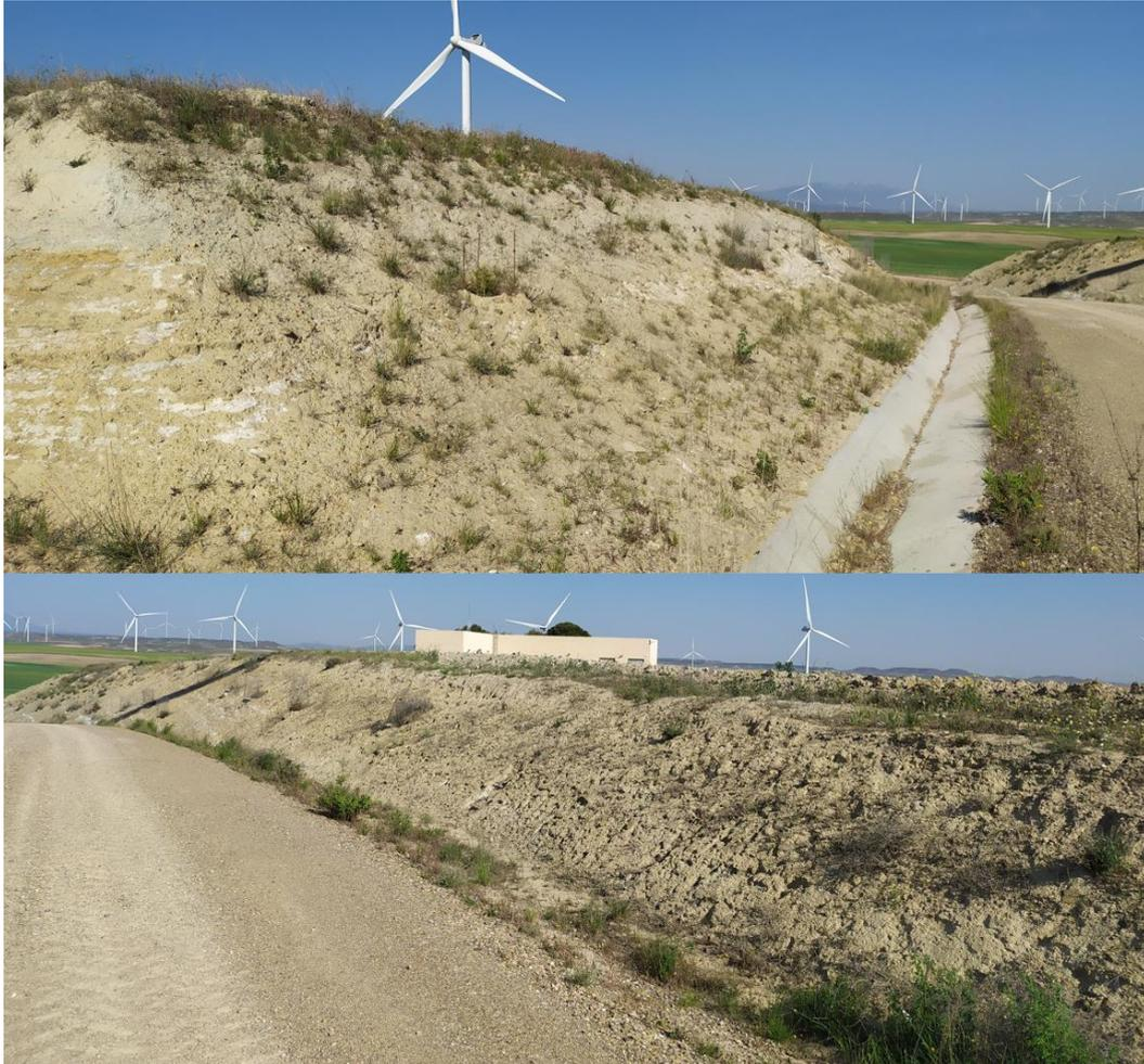
Figura 21: Fotografías de la vegetación natural espontánea creciendo en talud de la plataforma del ELL11 y del vial de acceso entre aerogeneradores ELL11 y ELL10, junto con especies arbustivas sembradas artificialmente.
