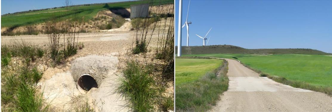
Figura 32: Fotografías del tubo de desagüe en plataforma de aerogenerador 8 y badén inundable en vial entre aerogeneradores ELL5 y ELL4.
