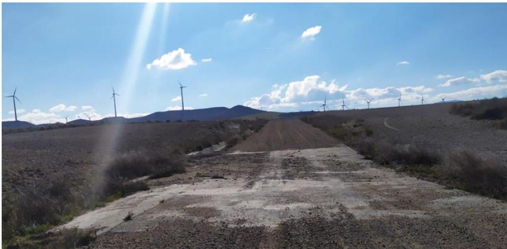
Figura 33: Badén inundable del vial de aerogeneradores ELL11, ELL12, ELL13 Y ELL14, enero 2022 con sedimentos de gravas y tierra arrastrados por las lluvias.
