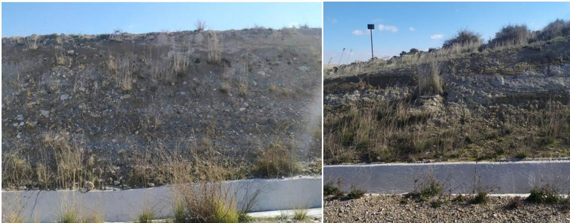
Figura 20: Fotografías de la vegetación natural espontánea creciendo en taludes de viales de acceso a los aerogeneradores del ELL12 al ELL14, junto con especies arbustivas sembradas artificialmente.
