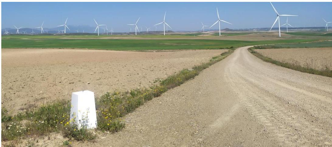
Figura 22: Vial de acceso entre aerogeneradores ELL9 y ELL10 con vegetación natural herbácea creciendo en sus laterales.
