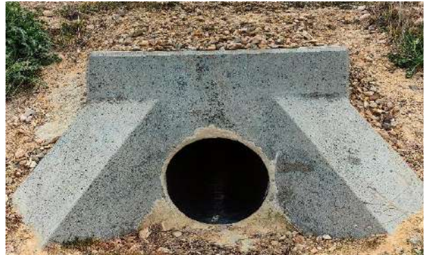
Foto nº34.: T-06: Drenaje del vial.
