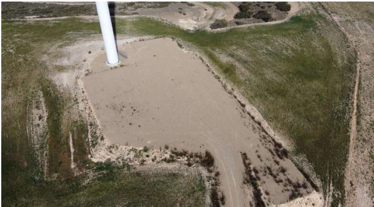
Foto nº12.: Plataforma del Aerogenerador T-12.
