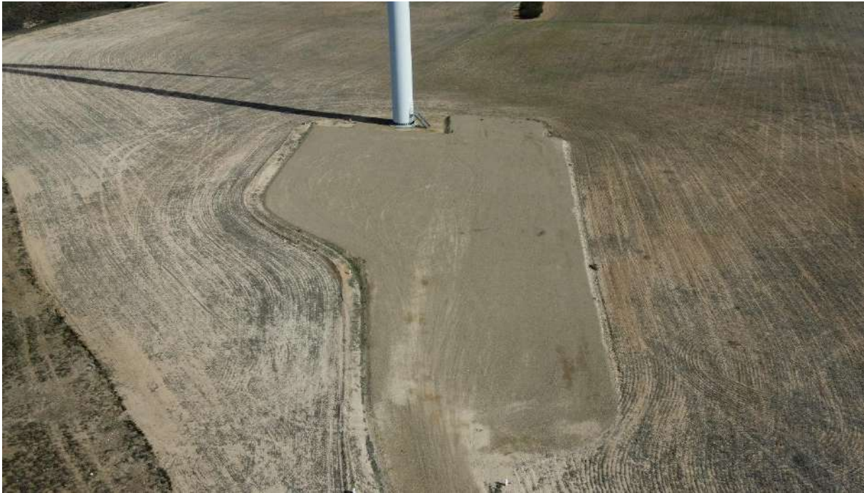
Foto nº3.: Plataforma del Aerogenerador T-03.
