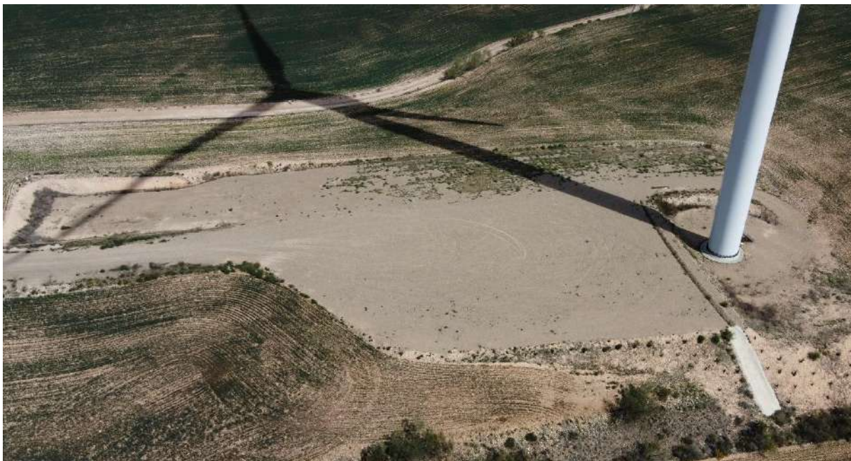
Foto nº6.: Plataforma del Aerogenerador T-06.
