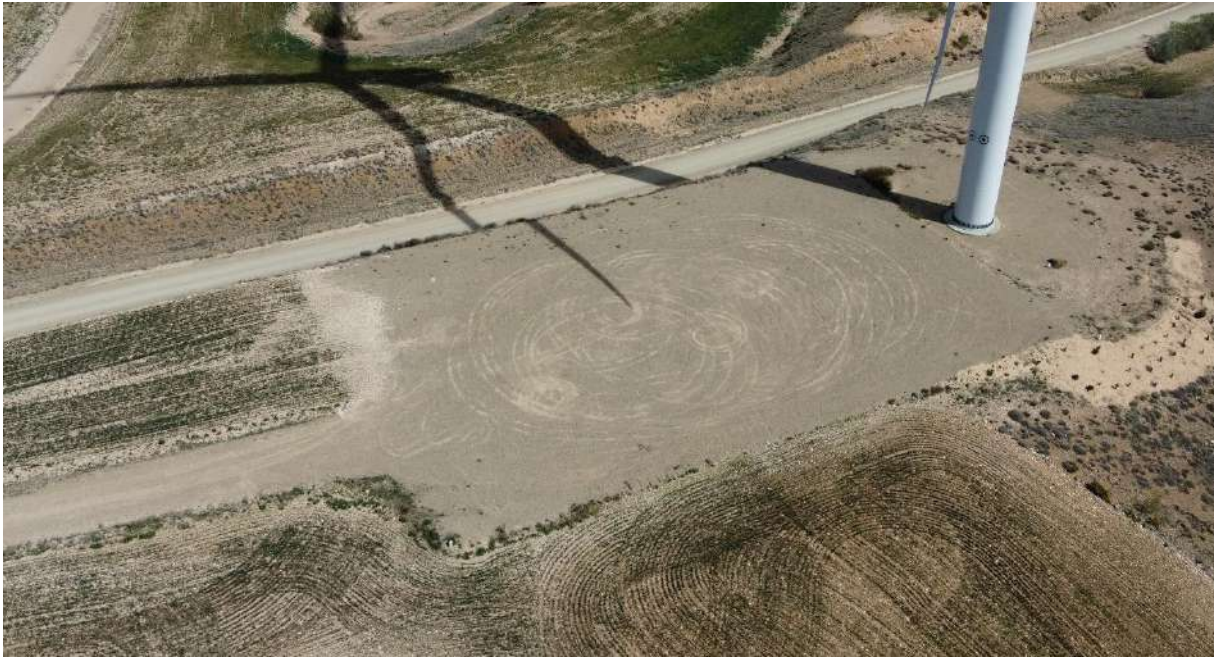
Foto nº13.: Plataforma del Aerogenerador T-13.
