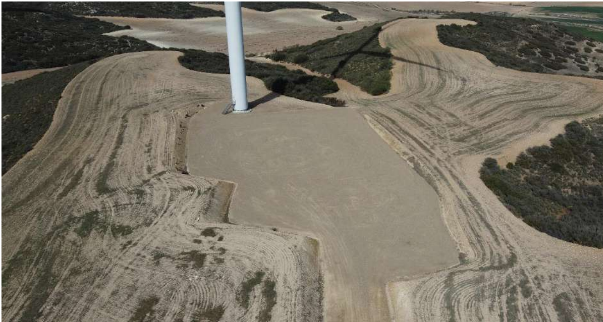
Foto nº2.: Plataforma del Aerogenerador T-02.
