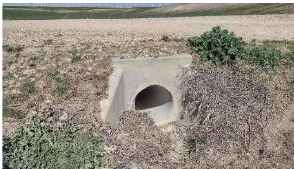
Foto nº39.: Drenaje de vial de acceso PE.
