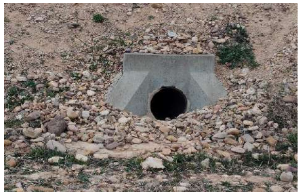
Foto nº36.: T-08: Drenaje del vial.
