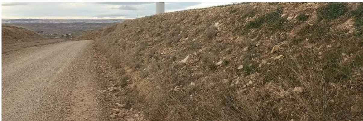
Foto nº29.: T-13: Hidrosiembra sobre talud en desmorte junto al camino de acceso.
