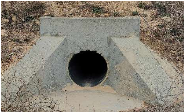
Foto nº34.: T-06: Drenaje del vial.
