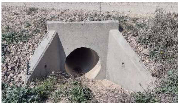
Foto nº38.: T-14: Drenaje del vial.
