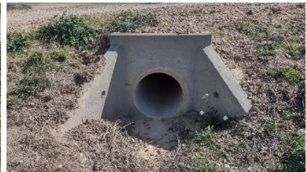
Foto nº39.: Drenaje de vial de acceso PE.
