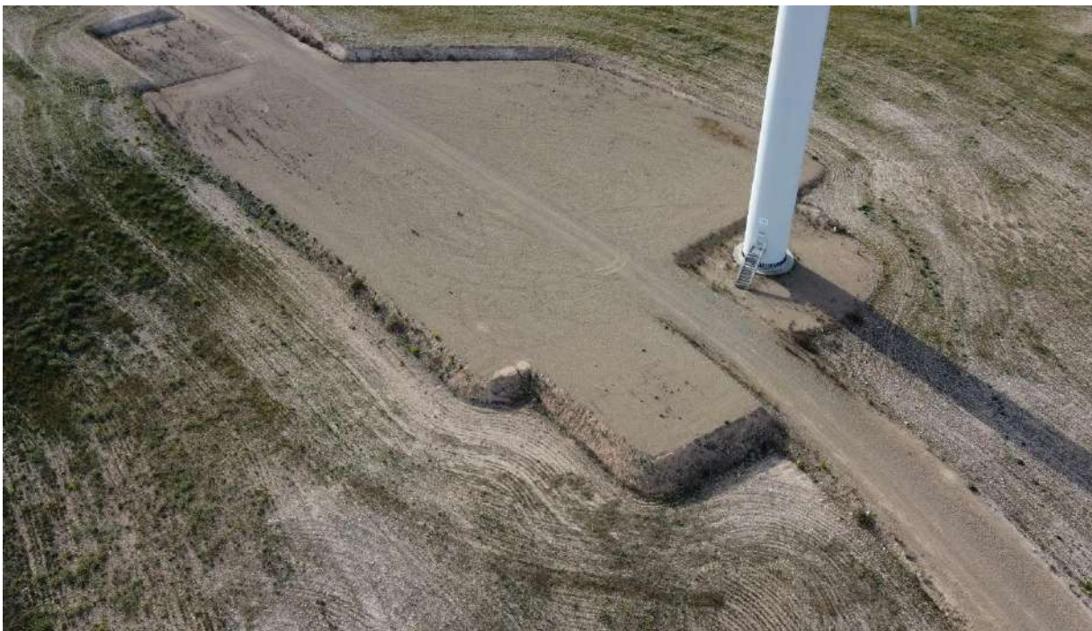
Foto nº10.: Plataforma del Aerogenerador T-10.
