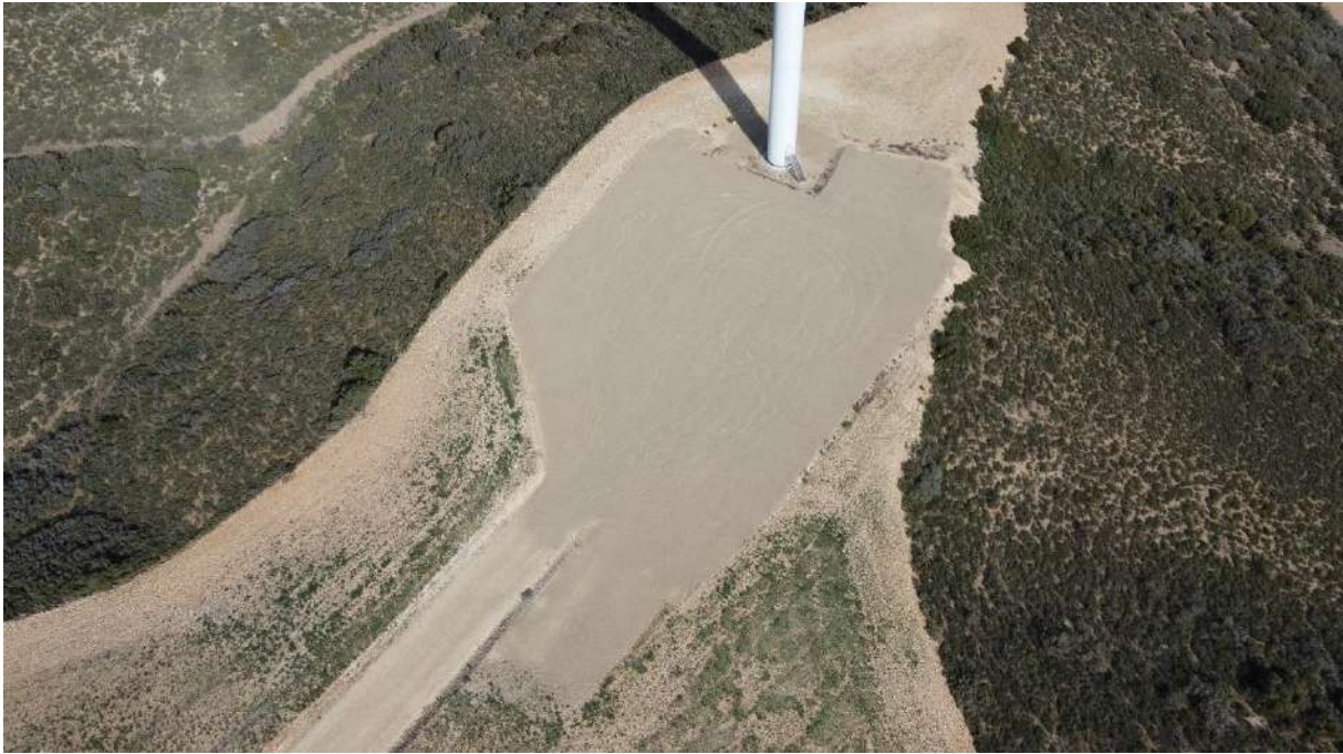
Foto nº1.: Plataforma del Aerogenerador T-01.
