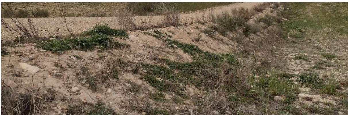
Foto nº28.: T-12: Plantación en el talud en terraplén del camino de acceso.
