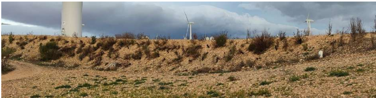
Foto nº23.: T-07: Plantación en el talud en terraplén del vial.
