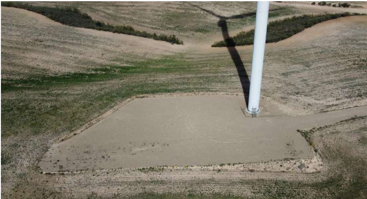
Foto nº4.: Plataforma del Aerogenerador T-04.
