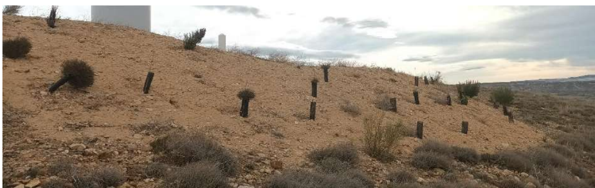
Foto nº30.: T-13: Plantación en el talud en terraplén de la plataforma.
