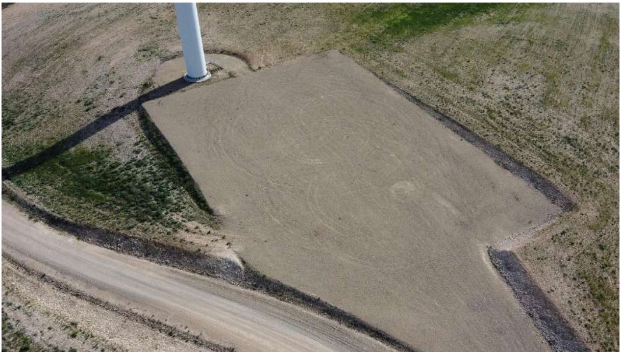
Foto nº8.: Plataforma del Aerogenerador T-08.
