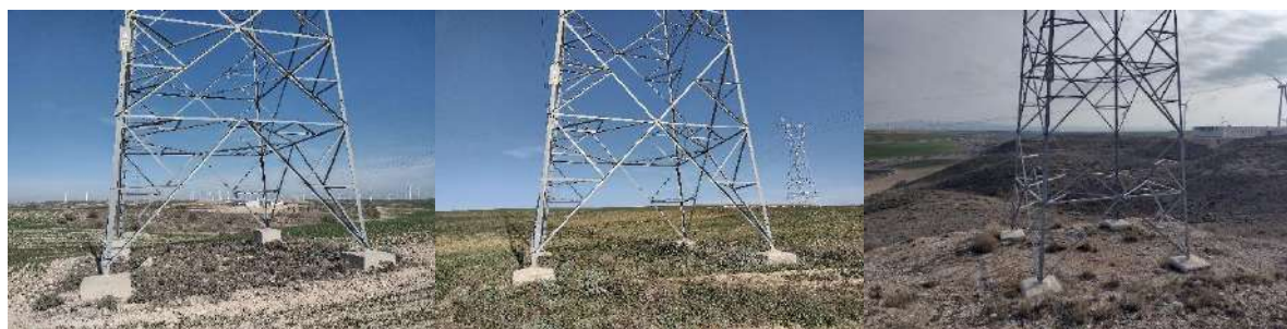
Foto nº17.: Estado general de los apoyos. Ejemplo del Apoyo nº 12, Apoyo nº 13 y Apoyo nº 14 de la LAAT.
