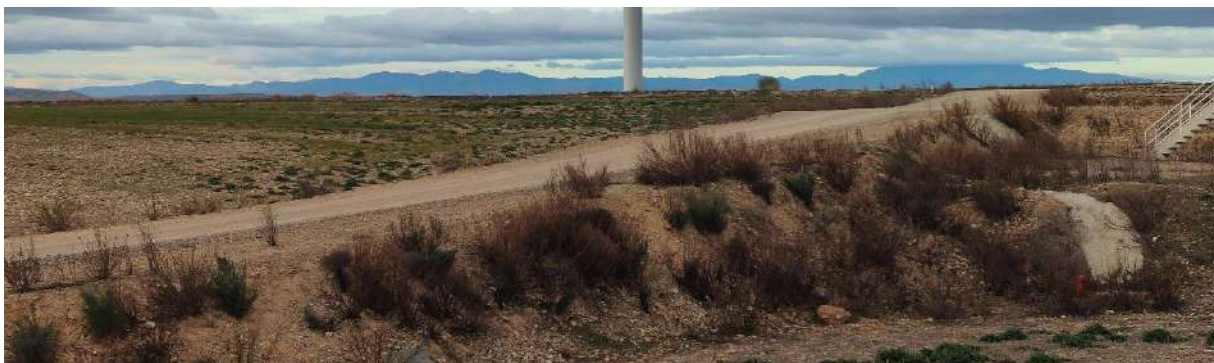
Foto nº24.: T-07:Detalle de plantación en el talud en terraplén de la plataforma.
