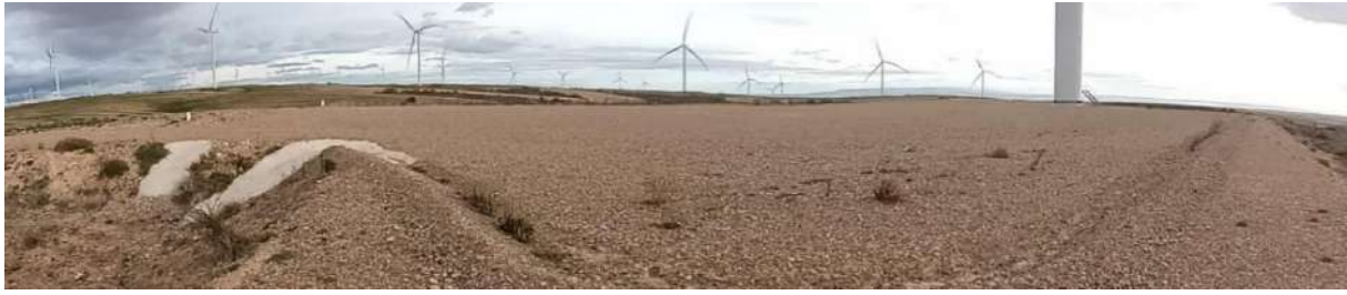
Foto nº37.: T-14: Drenaje en la plataforma.
