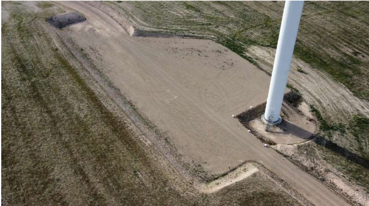
Foto nº11.: Plataforma del Aerogenerador T-11.
