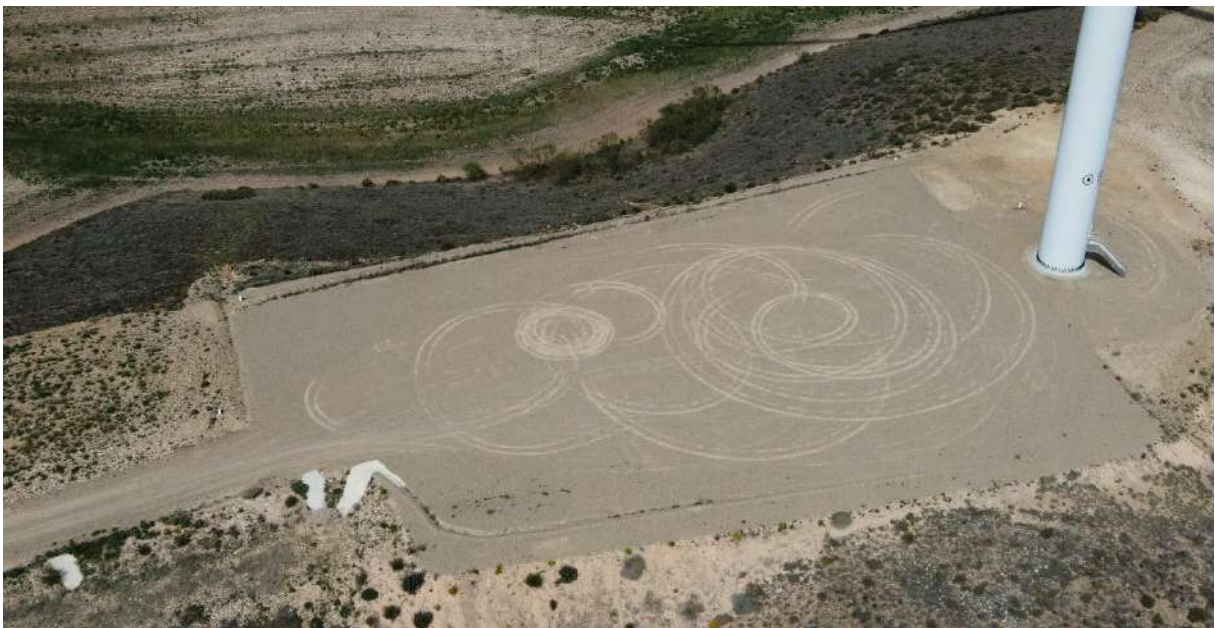
Foto nº14.: Plataforma del Aerogenerador T-14.
