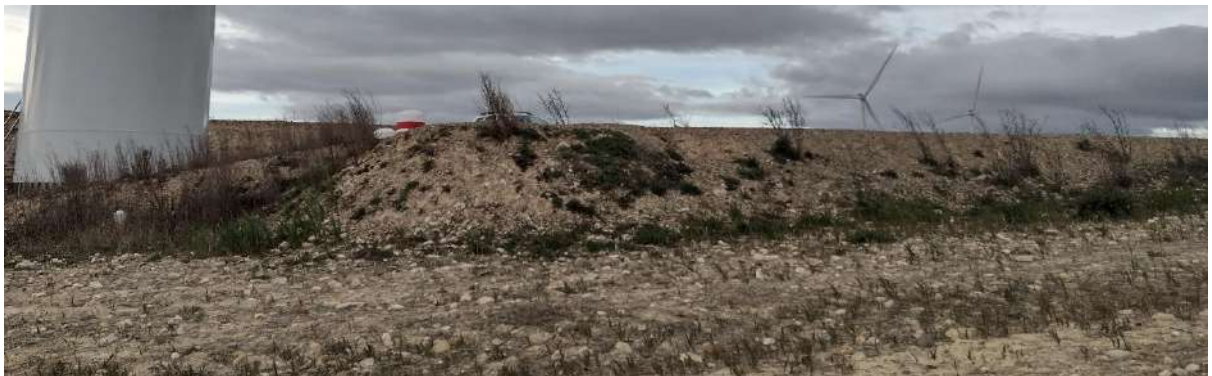
Foto nº26.: T-11: Hidrosiembra en el talud en terraplén de la plataforma.
