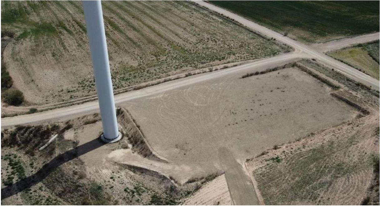
Foto nº7.: Plataforma del Aerogenerador T-07.
