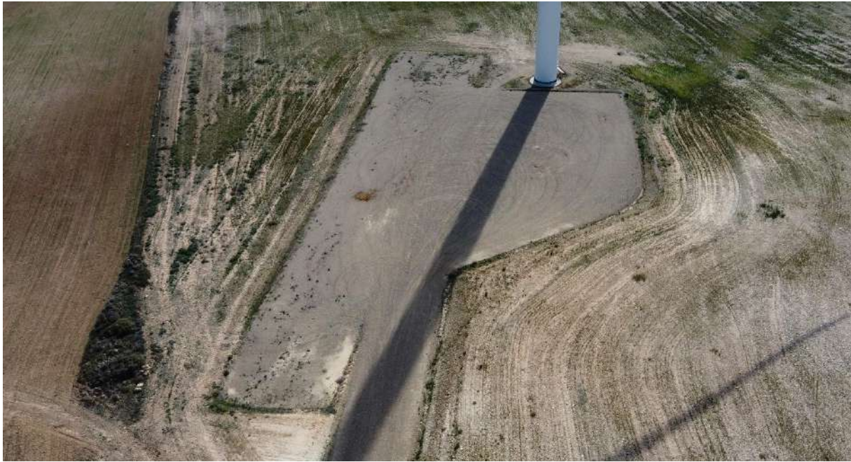
Foto nº5.: Plataforma del Aerogenerador T-05.
