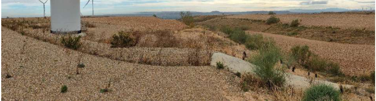
Foto nº33.: T-06: Canalización de agua para evitar escorrentías por el talud.
