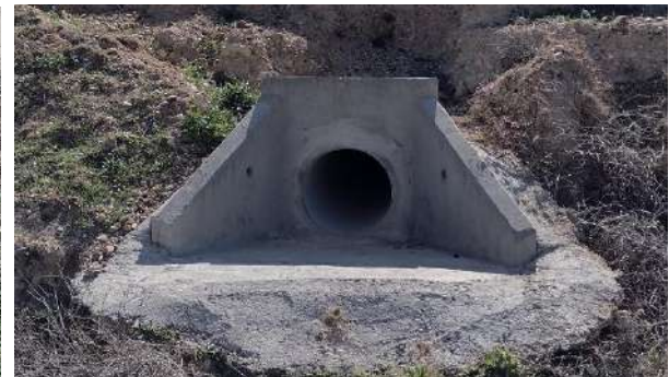
Foto nº38.: T-14: Drenaje del vial.
