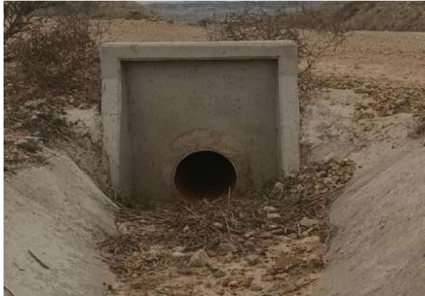
Foto nº38.: T-14: Drenaje del vial.
