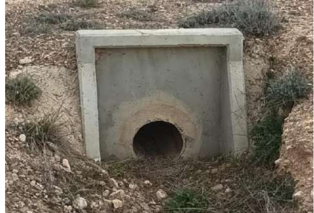
Foto nº38.: T-14: Drenaje del vial.
