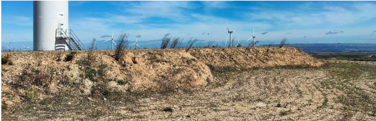
Foto nº25.: T-10: Hidrosiembra en el talud en terraplén de la plataforma.
