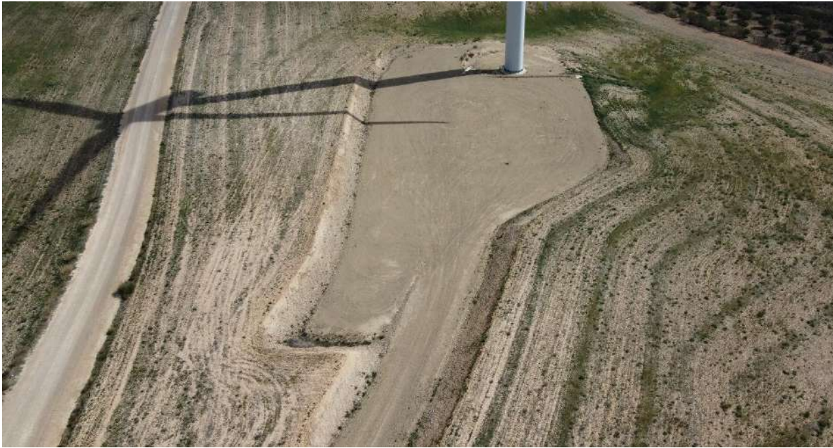
Foto nº9.: Plataforma del Aerogenerador T-09.
