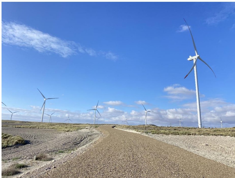
Figura 11: Vial perteneciente al Aerogenerador CDM-01.
