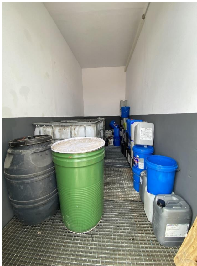
Figura 14: Interior del almacén de residuos de la SET “Campo de Magallón”, con los diferentes residuos peligrosos clasificados, aislados de la intemperie y sobre una tarima aislante para evitar posibles filtraciones al suelo.
