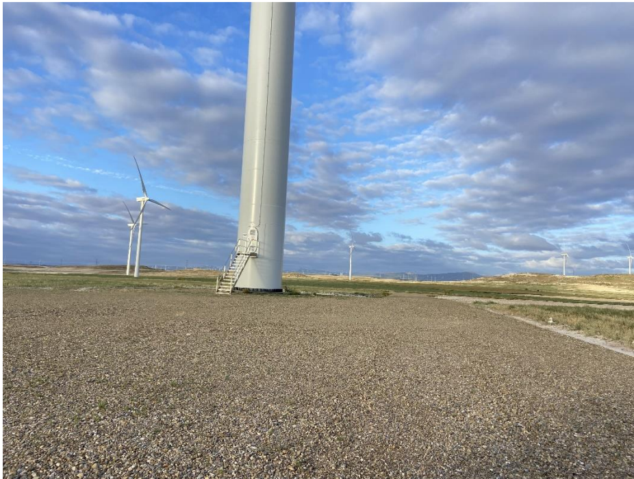
Figura 13: Vial perteneciente al Aerogenerador CDM-03.
