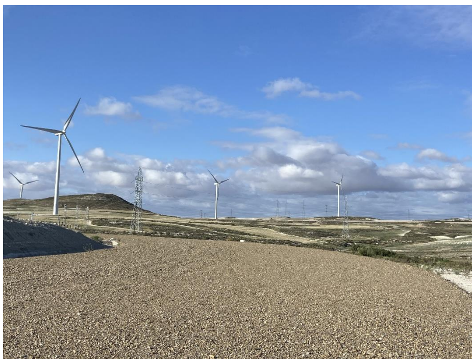
Figura 12: Vial perteneciente al Aerogenerador CDM-02.
