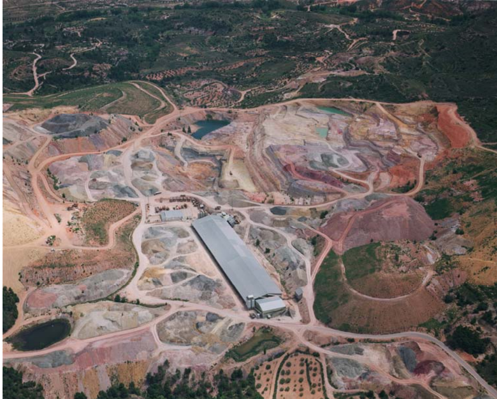
Detalle de la explotación e instalaciones
