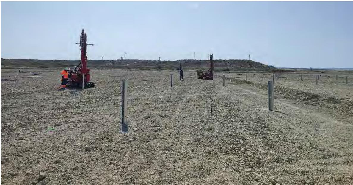
**Ilustración 3.** Trabajos hincadora y colocación de hincas.
