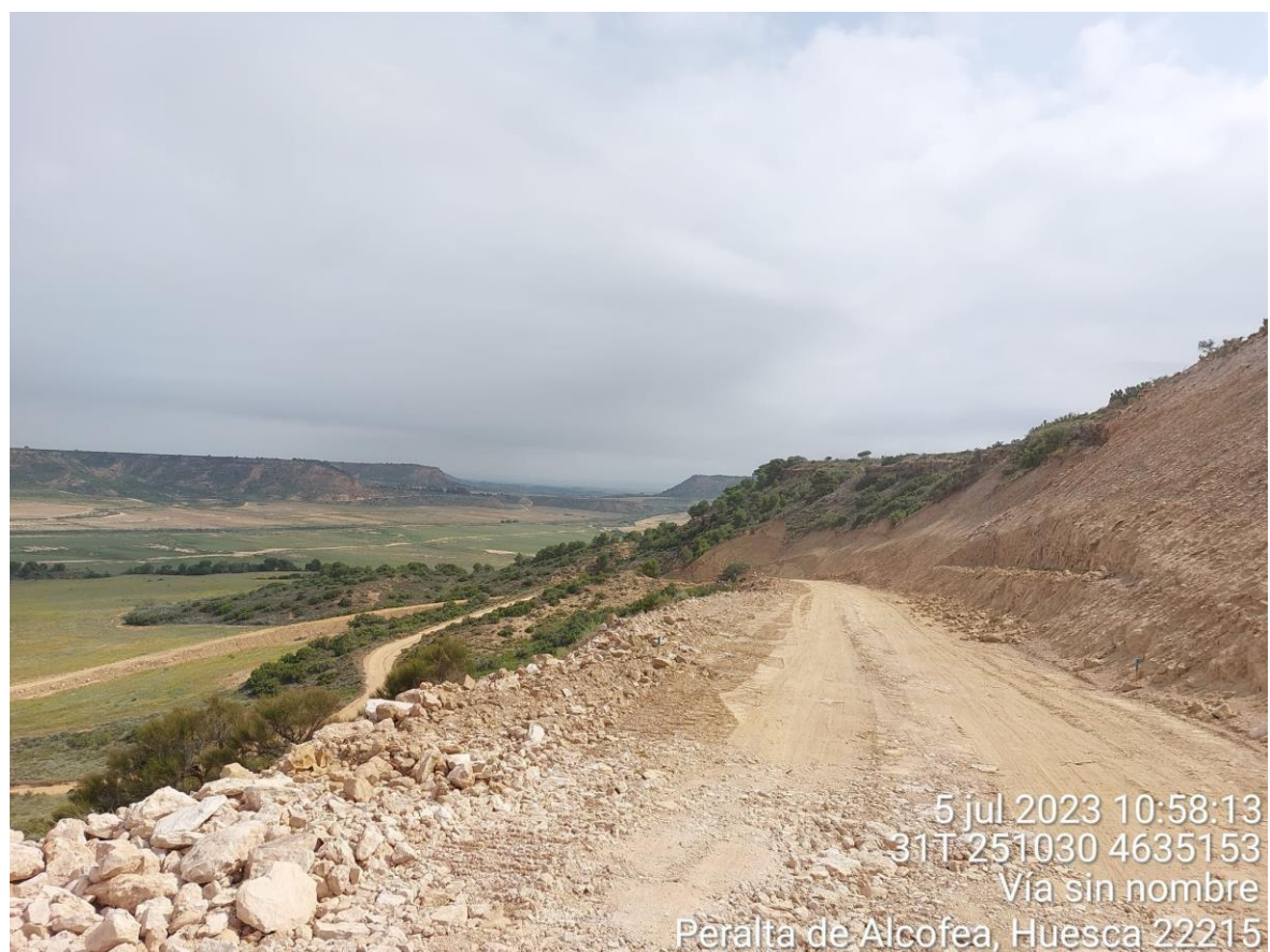
Imagen 2. Tramo del vial entre SET y SC1. Vial que se debe regar.
