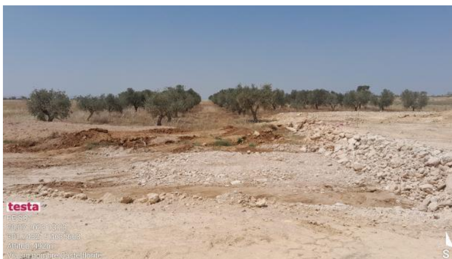
Restauración de pozo en SC2.
