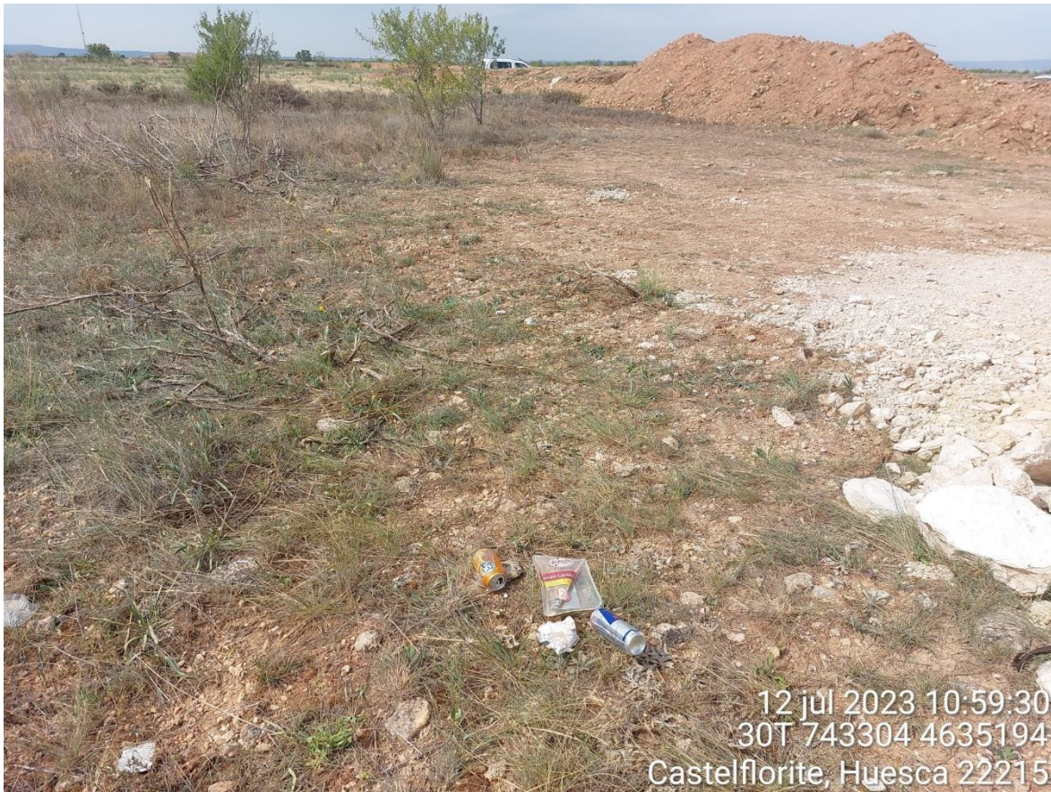
Imagen 2. Residuos (latas, envases, etc.) en la plataforma hormigonada la anterior semana.
