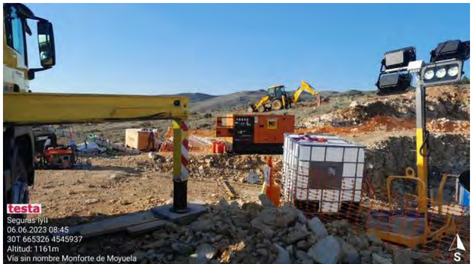
Aislamiento de suelo en bomba y otros equipos
