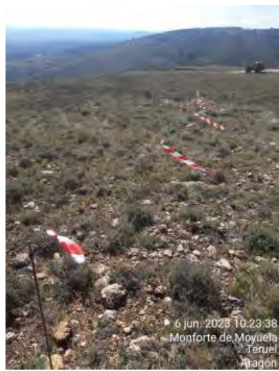
Correcto estaquillado en SE2-4
