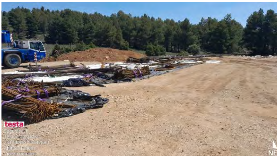
Ferralla con manta de protección de suelos.
