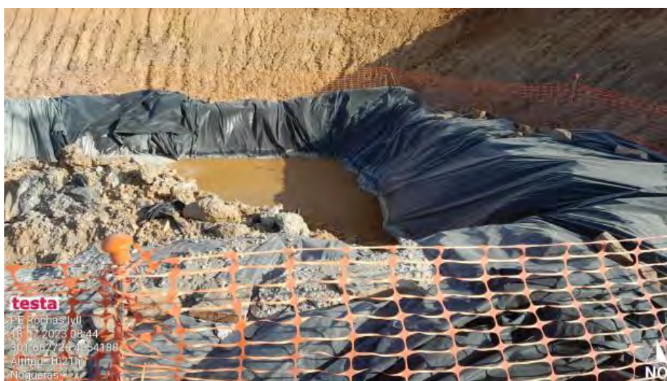
Pozo de lavado tras terminar todos los trabajos de hormigón en RH1-4
