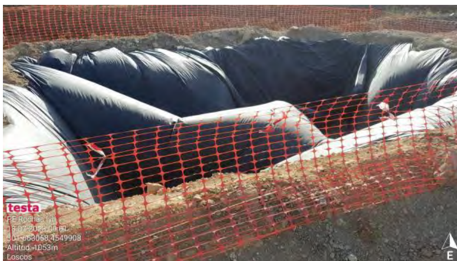
Nuevo pozo de Lavado en RH1-1
