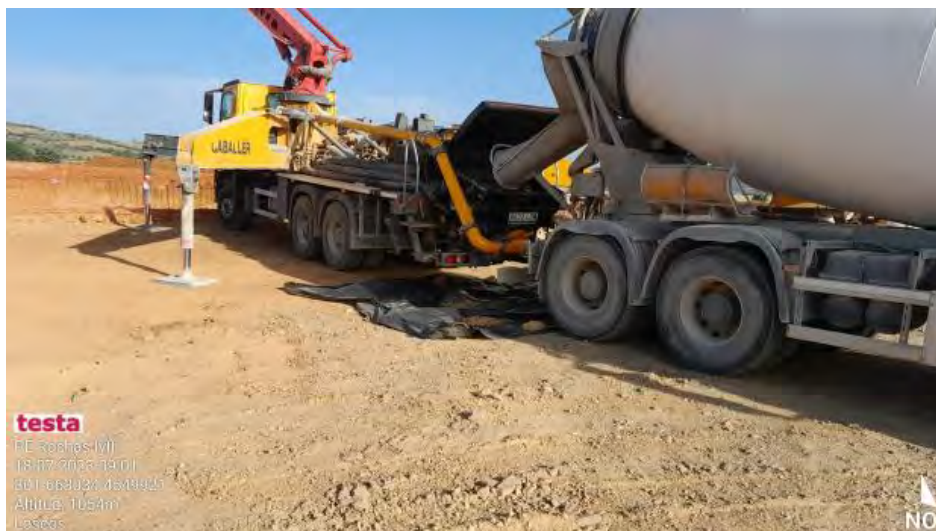
Hormigonado en RH1-1
