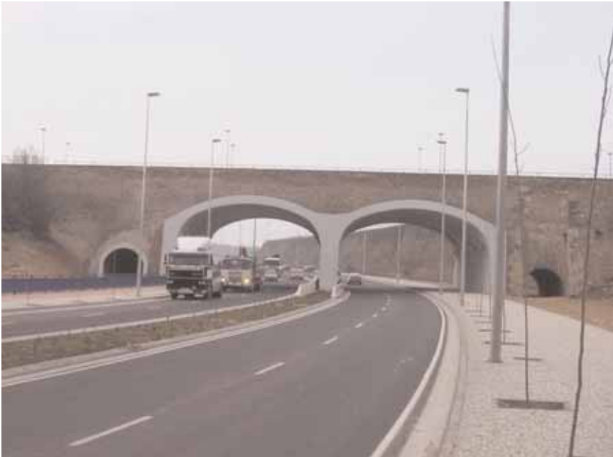
La autovía a su paso por el Canal Imperial de Aragón (Zaragoza)
