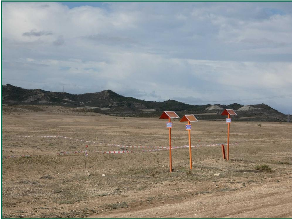
Fotografía 2. Balizamiento del gasoducto.
