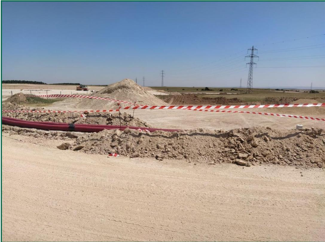
Fotografía 2. Balizado de línea soterrada.
