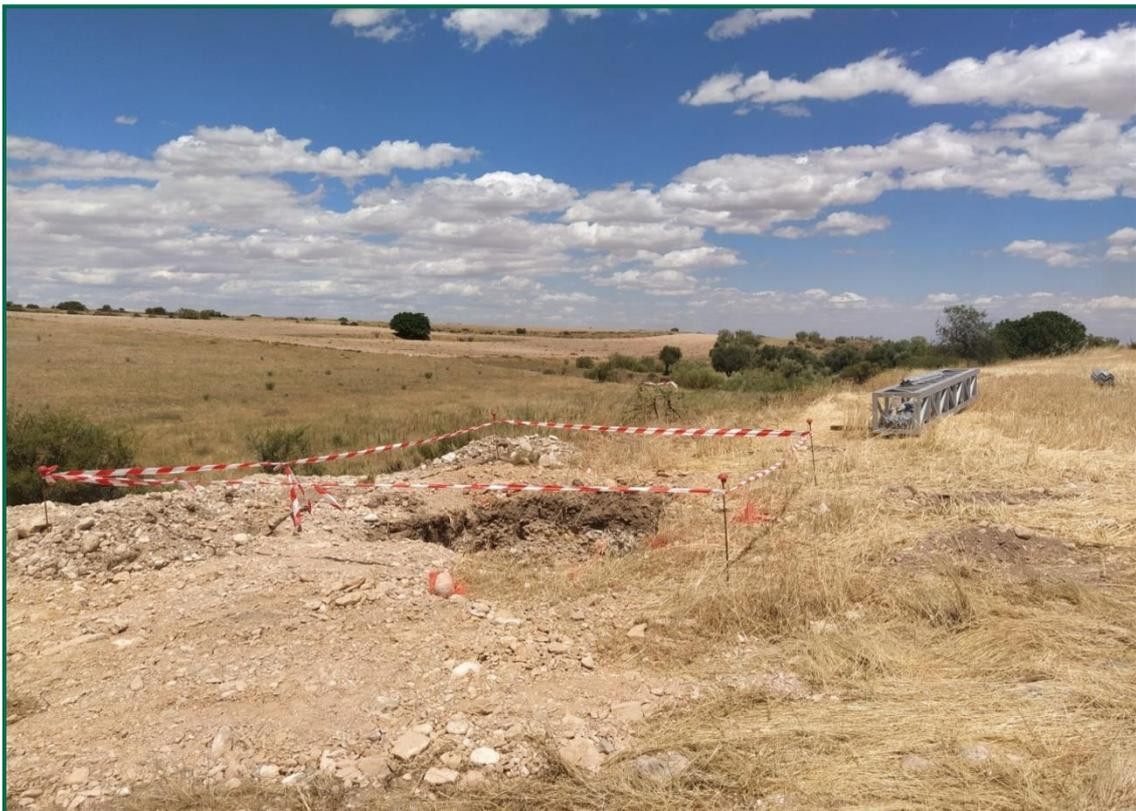
Fotografía 1. Balizado de apoyo excavado.
