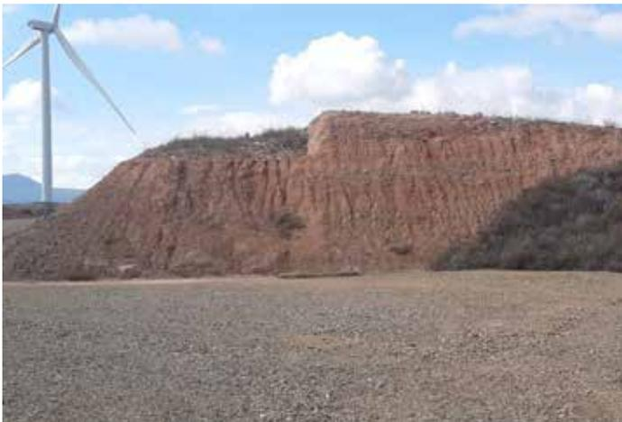
Fig. 3 Erosión hídrica en materiales lutíticos del talud de desmonte de plataforma del aereo VR2.07. Fuente: Elaboración propia
