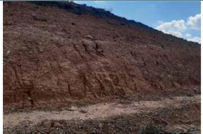
Fig. 2 Erosión hídrica en materiales lutíticos del talud de desmonte del vial de acceso al aereo VR2.14. Fuente: Elaboración propia
