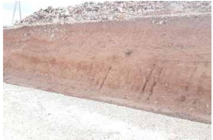
Fig. 4 Erosión hídrica en materiales lutíticos del talud de desmonte del vial de acceso al aereo VR2.11. Fuente: Elaboración propia
