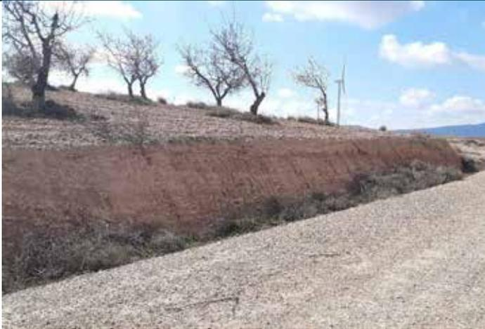
Fig. 1 Erosión hídrica en materiales lutíticos del talud de desmonte del vial de acceso al aereo VR2.13. Fuente: Elaboración propia
