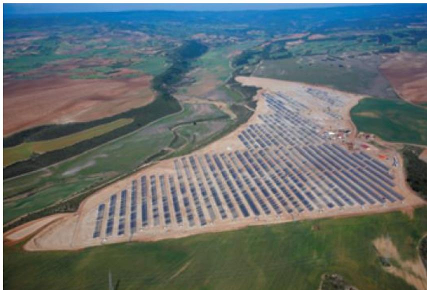
Instalación solar fotovoltaica de 9 MW con seguidor de 1 eje (Zuera, Zaragoza)
